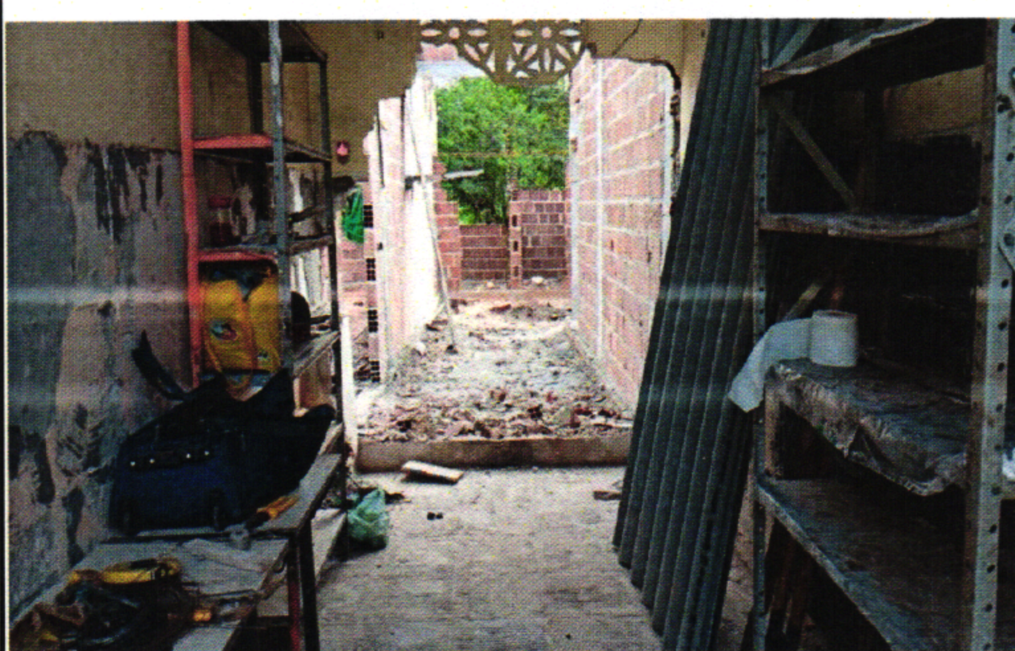
ESCOLA MUNICIPAL DUQUE DE CAXIAS - DEMOLIÇÃO DE ALVENARIA
