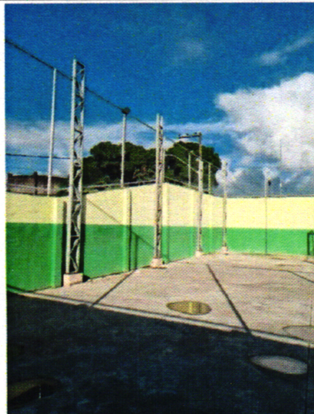
ESCOLA MUNICIPAL INACIO GOMES - SAPATAS E PIARES DA QUADRA
