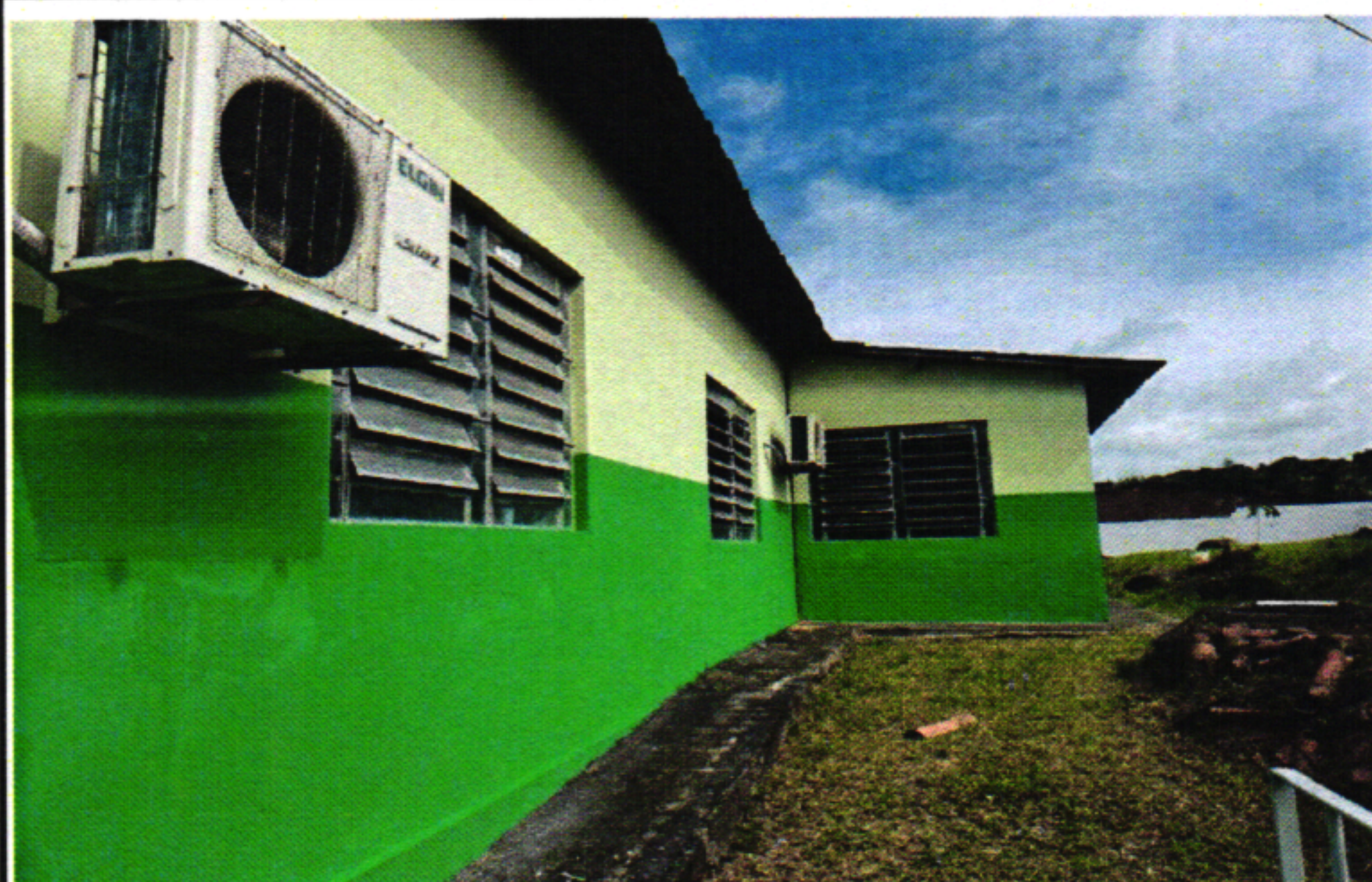
ESCOLA MUNICIPAL PAULO GOMES - PINTURA ESMALTE SINTÉTICO SOBRE SUPERFÍCIES METÁLICAS
