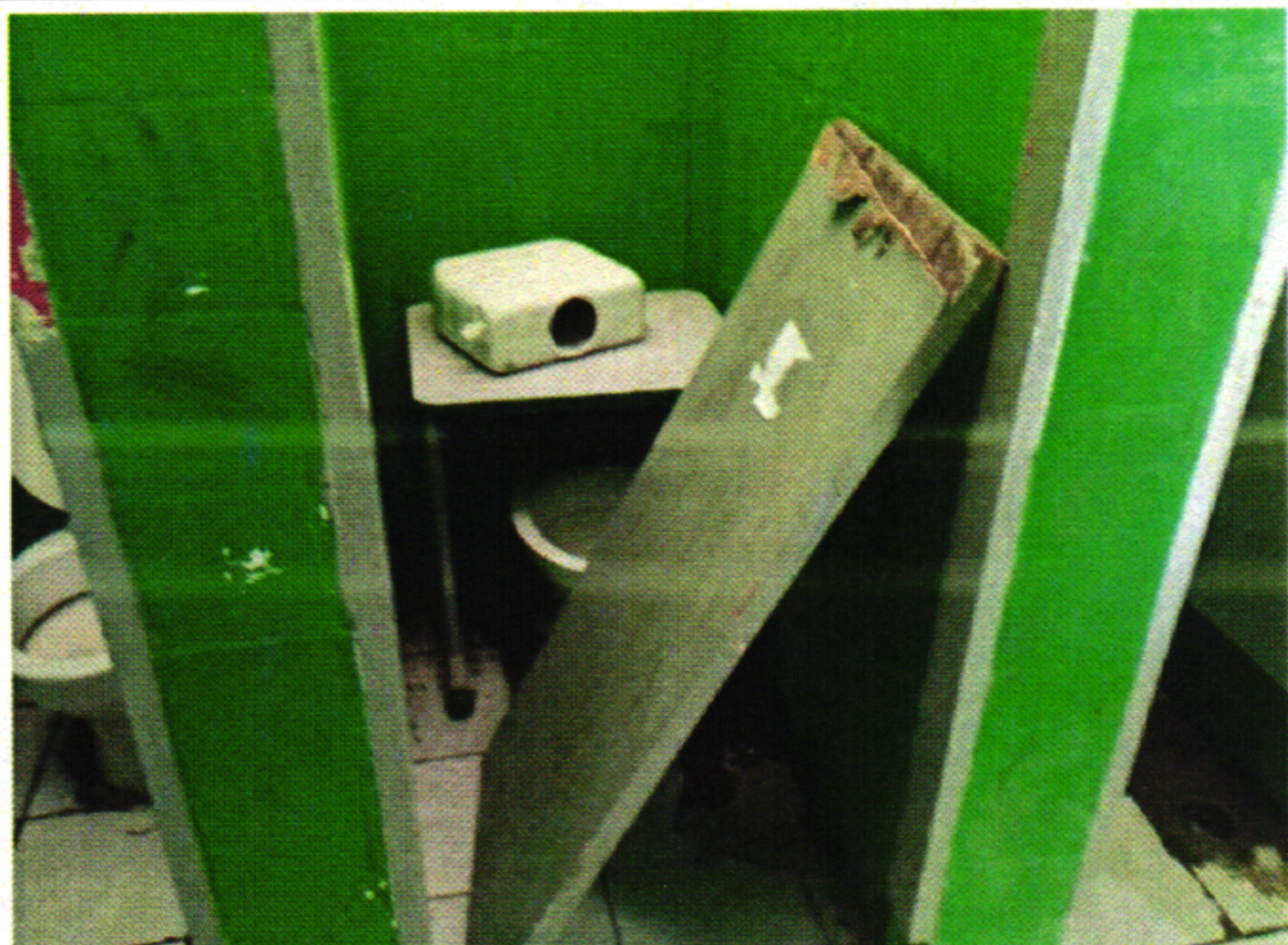
ESCOLA MUNICIPAL INACIO GOMES - REMOÇÃO DE PORTAS E DE LOUÇAS SANITÁRIAS
