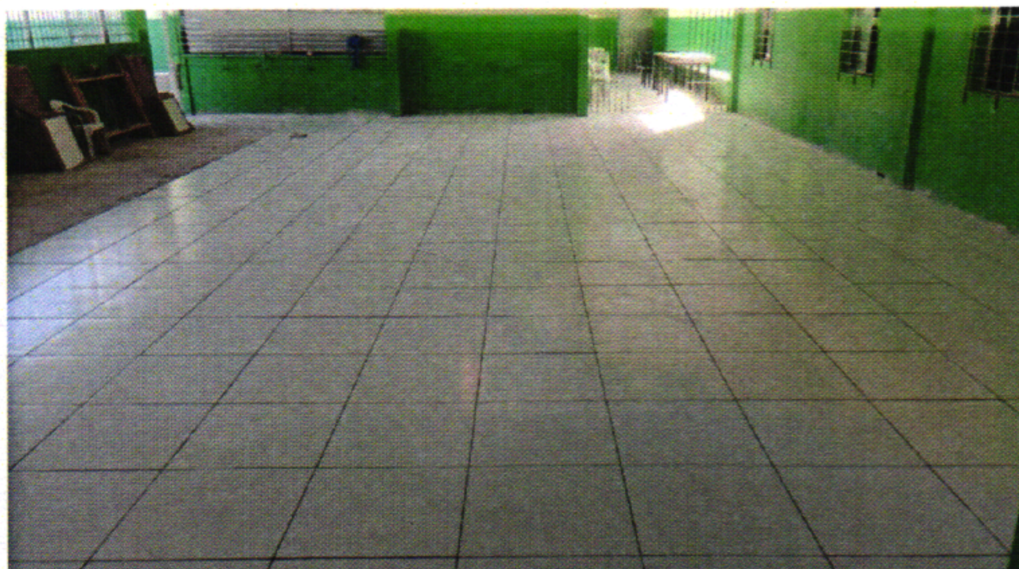
ESCOLA MUNICIPAL INACIO GOMES - REVESTIMENTO CERÂMICO DE PISO
