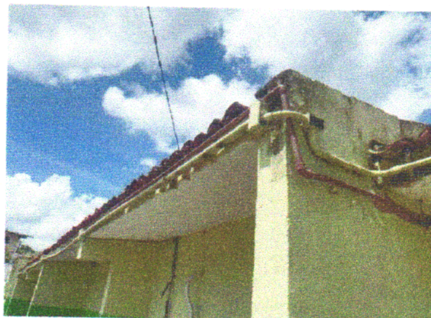
ESCOLA MUNICIPAL APOLÔNIO SALES - CHEGADA DE ÁGUA FRIA
