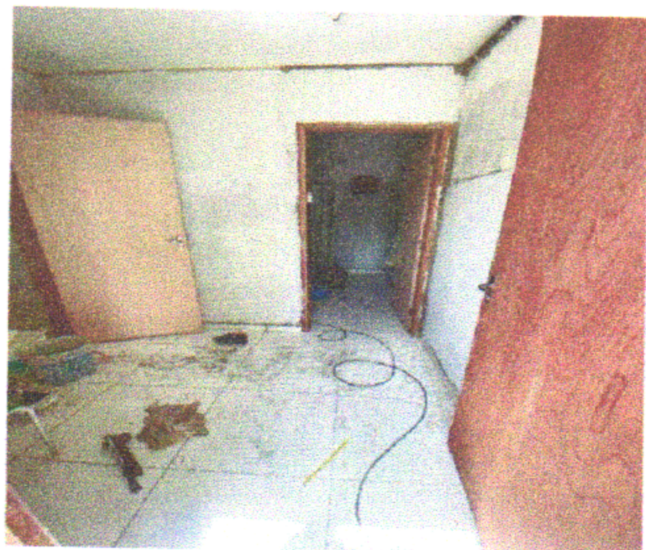
ESCOLA MUNICIPAL APOLÔNIO SALES - REBOCO, REVESTIMENTO, INSTALAÇÃO DE PORTAS
