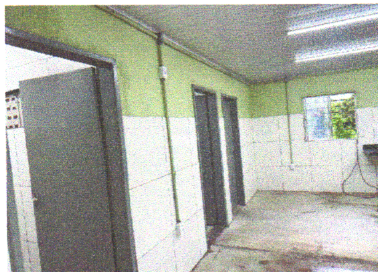
ESCOLA MUNICIPAL ROSINA LABANCA - PORTAS, JANELAS, REVESTIMENTO CERÂMICO, COBOGÓ
