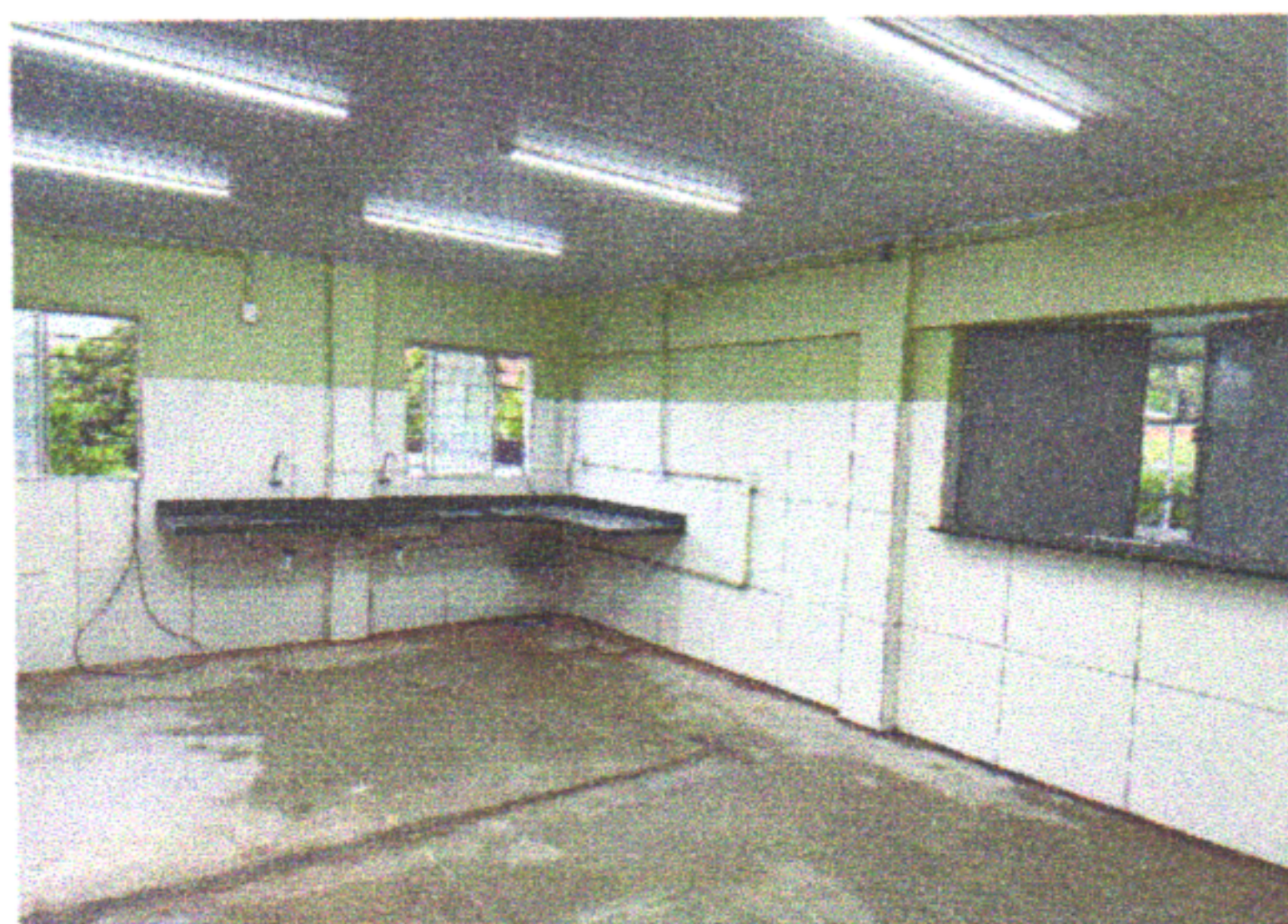
ESCOLA MUNICIPAL ROSINA LABANCA - BANCADAS DE GRANITO, REVESTIMENTO CERÂMICO, LUMINÁRIAS, FORRO PVC E JANELAS
