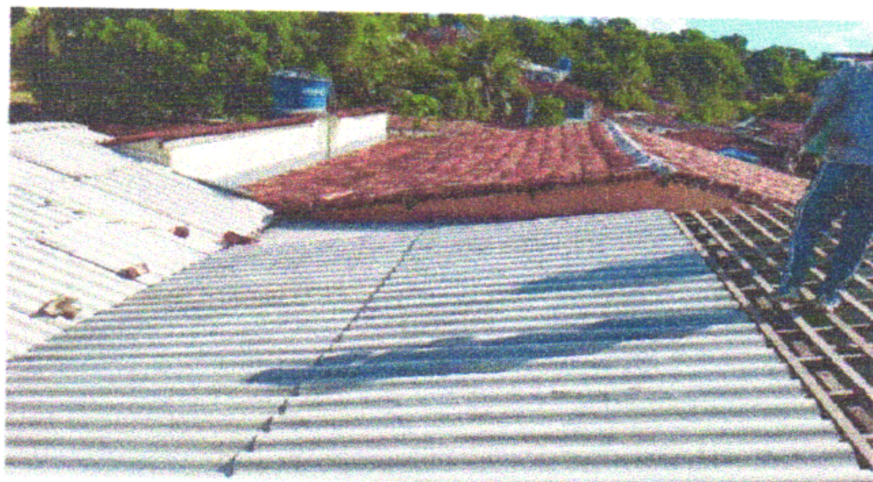
ESCOLA MUNICIPAL JOÃO BARBALHO - COBERTA
