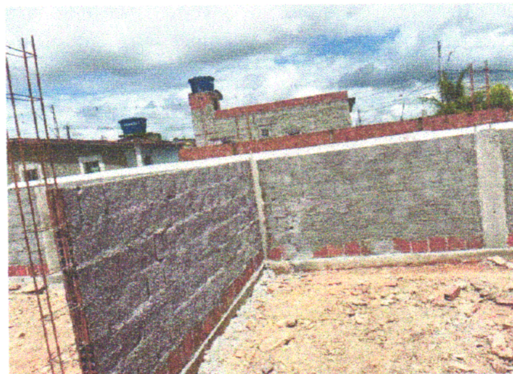
ESCOLA MUNICIPAL CARMELA ORRICO - ESTRUTURA, ALVENARIA E CHAPISCO
