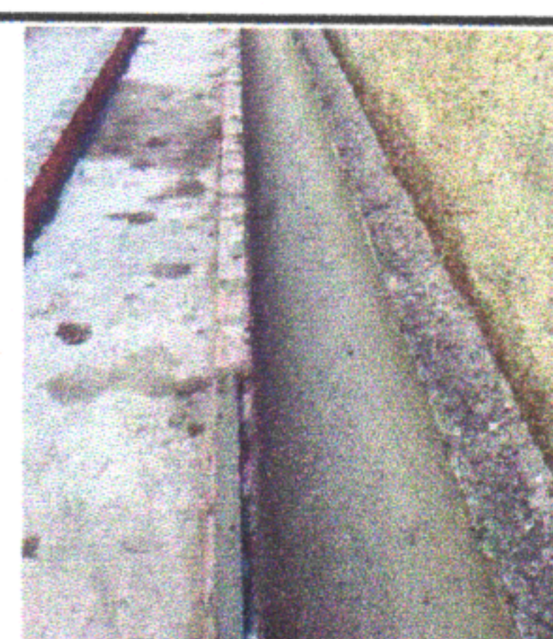
ESCOLA MUNICIPAL CLETO CAMPELO (ANEXO II) - ALVENARIA PARA APOIO DAS TELHAS E IMPERMEABILIZAÇÃO NA CALHA
