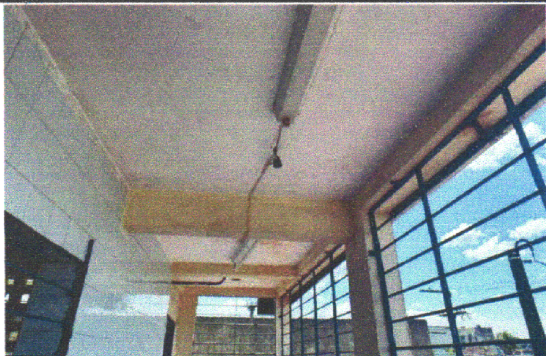
ESCOLA MUNICIPAL CLETO CAMPELO (ANEXO II) - REMOÇÃO DE LUMINÁRIAS
