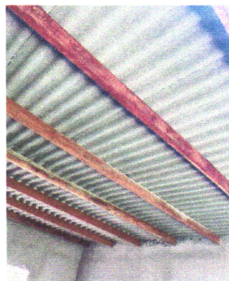
ESCOLA MUNICIPAL JOAQUIM DE BRITO - COBERTA
