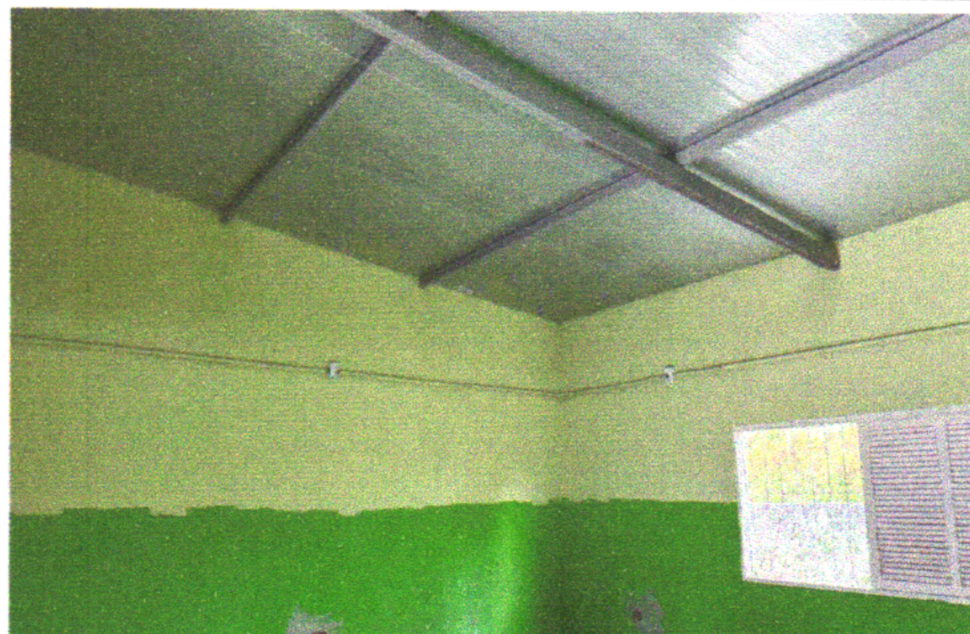
ESCOLA MUNICIPAL ROSINA LABANCA - ESTRUTURA METÁLICA E TELHAMENTO
