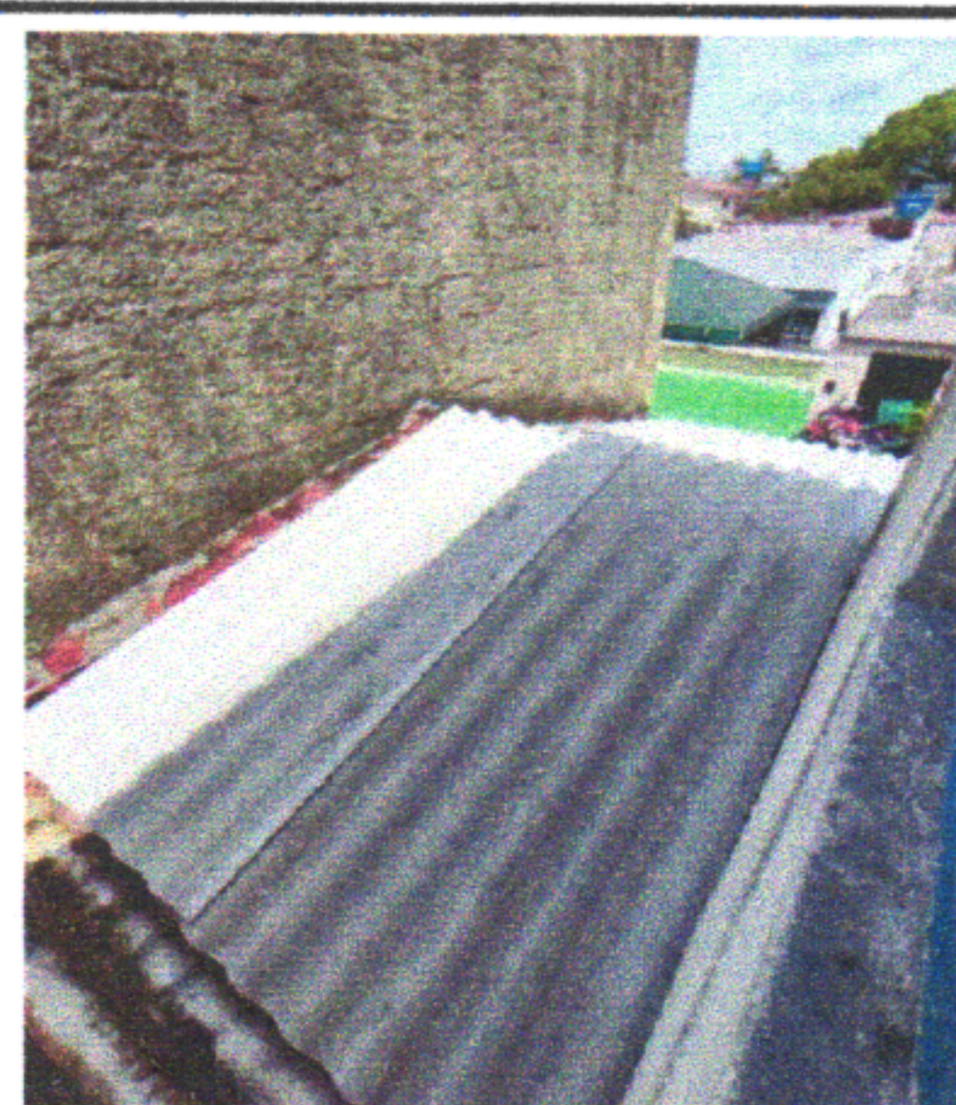
ESCOLA MUNICIPAL CLETO CAMPELO (ANEXO II) - TELHAMENTO COM TELHA ONDULADA DE FIBROCIMENTO
