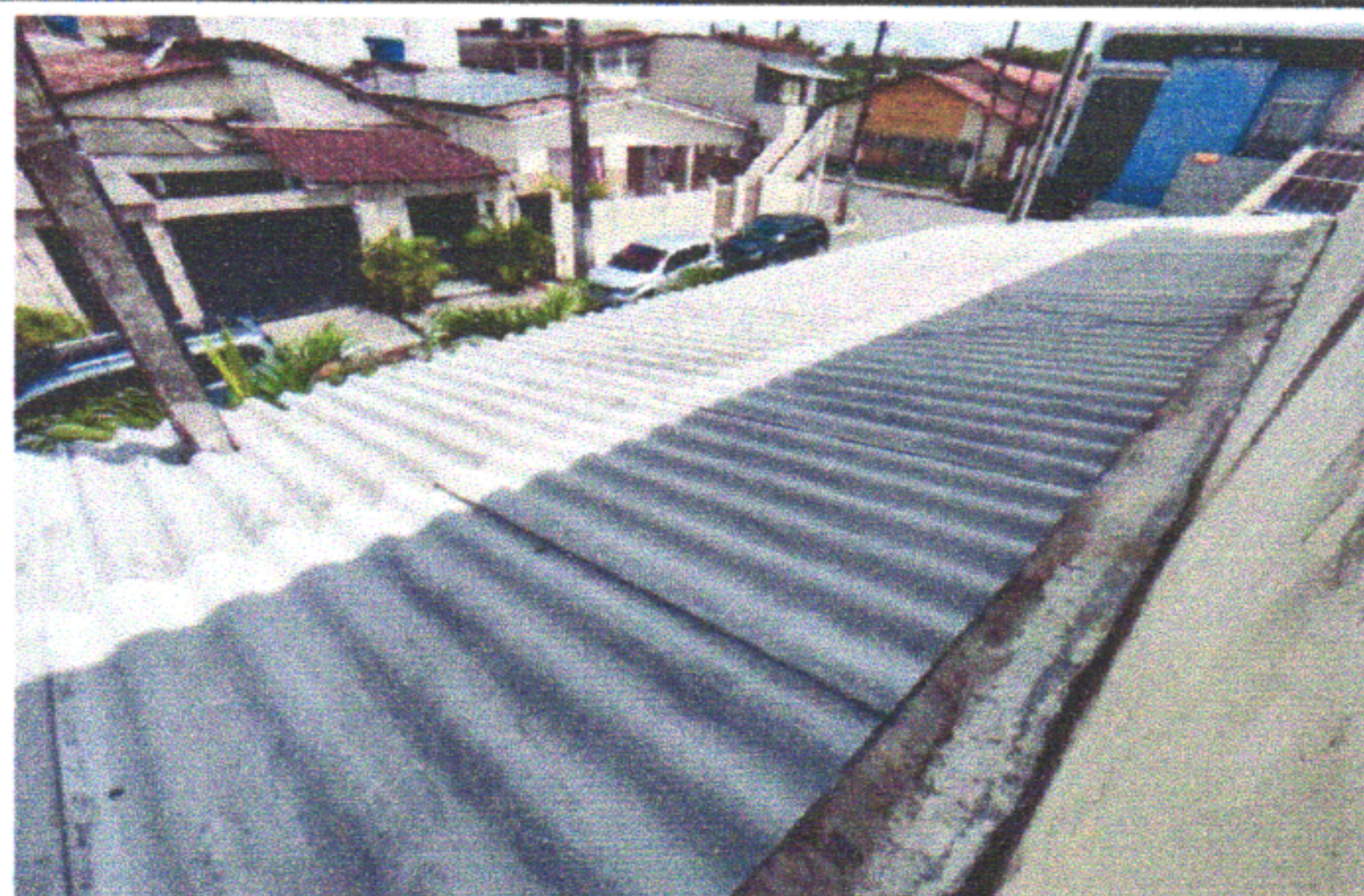
ESCOLA MUNICIPAL CLETO CAMPELO (ANEXO II) - TELHAMENTO COM TELHA ONDULADA DE FIBROCIMENTO
