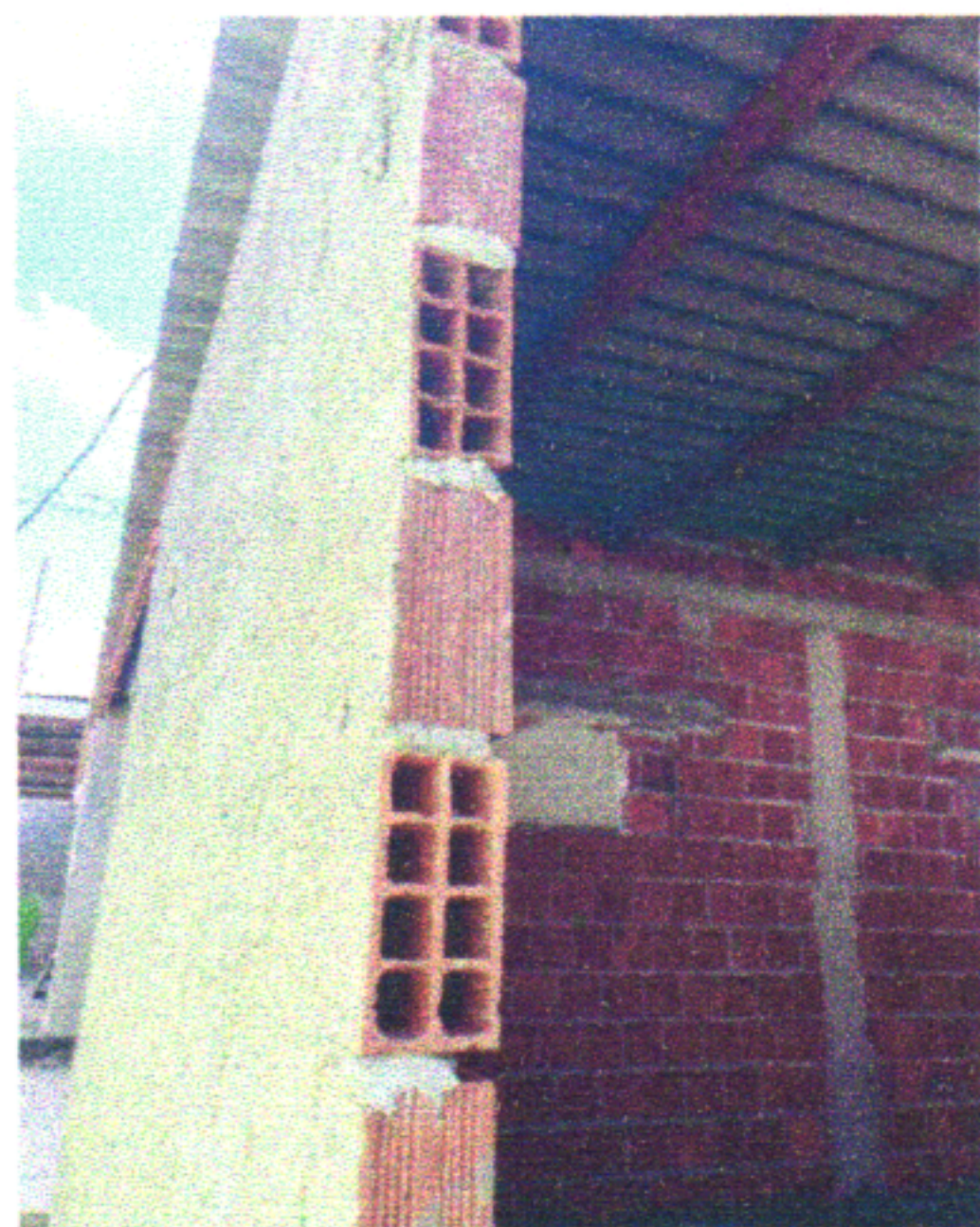
ESCOLA MUNICIPAL JOAQUIM DE BRITO - ALVENARIA
