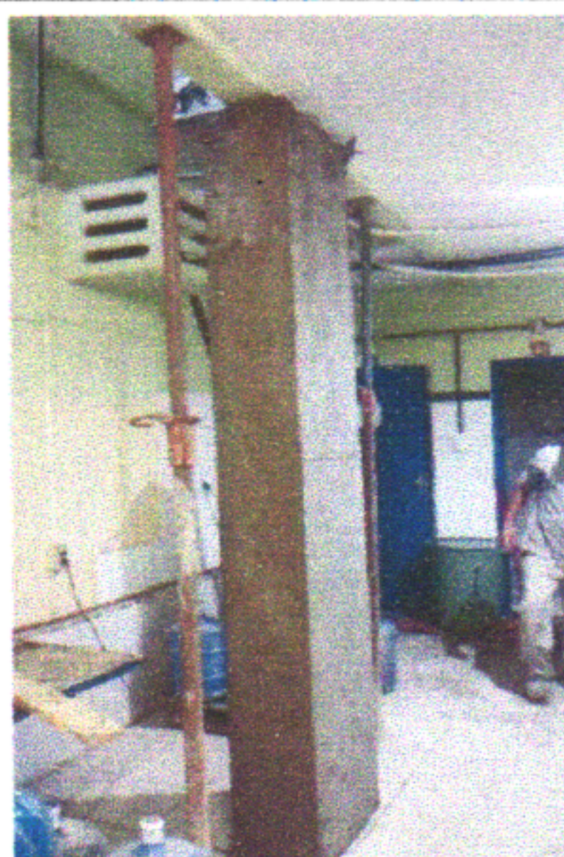
ESCOLA MUNICIPAL CLETO CAMPELO (ANEXO II) - SERVIÇO DE RECUPERAÇÃO DA ESTRUTURA (REPOSIÇÃO DE ARMADURA E CONCRETAGEM)
