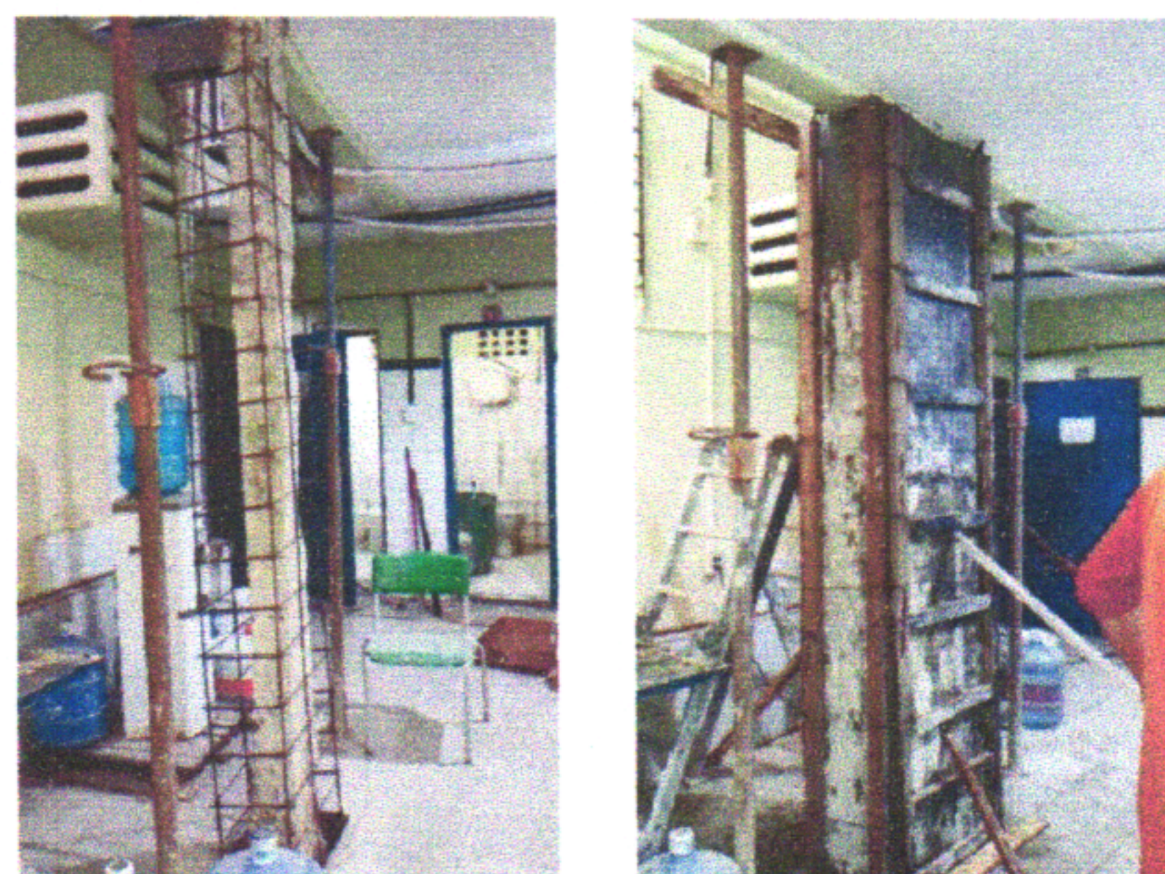
ESCOLA MUNICIPAL CLETO CAMPELO (ANEXO II) - SERVIÇO DE RECUPERAÇÃO DA ESTRUTURA (REPOSIÇÃO DE ARMADURA E CONCRETAGEM)
