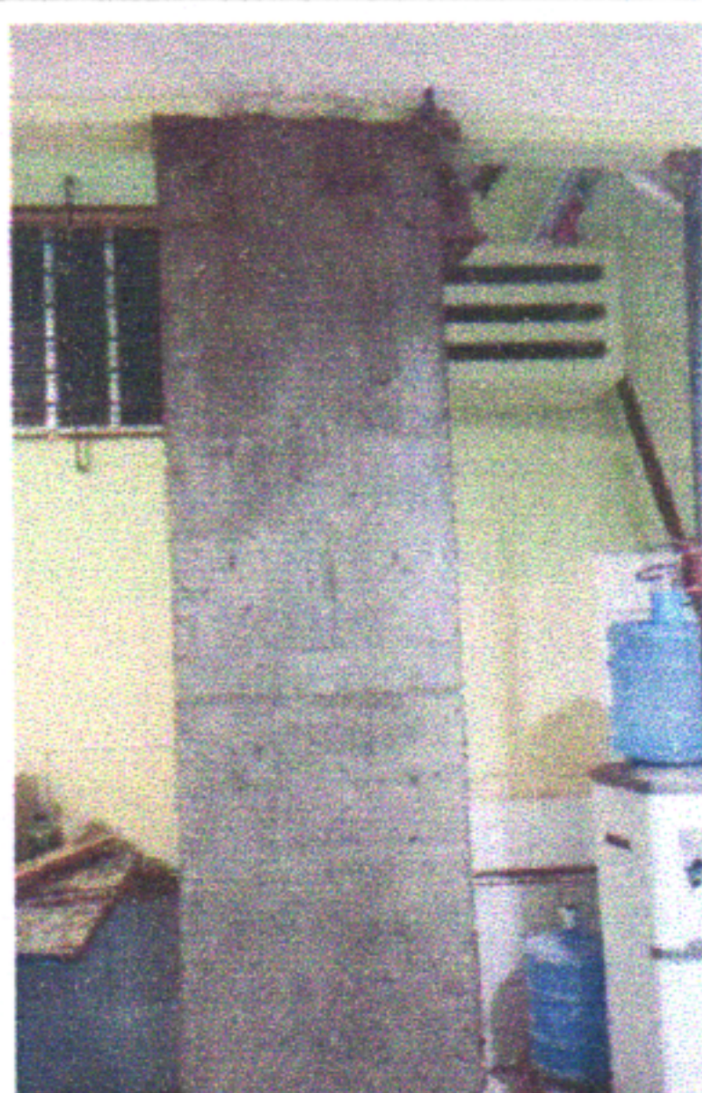
ESCOLA MUNICIPAL CLETO CAMPELO (ANEXO II) - SERVIÇO DE RECUPERAÇÃO DA ESTRUTURA (REPOSIÇÃO DE ARMADURA E CONCRETAGEM)
