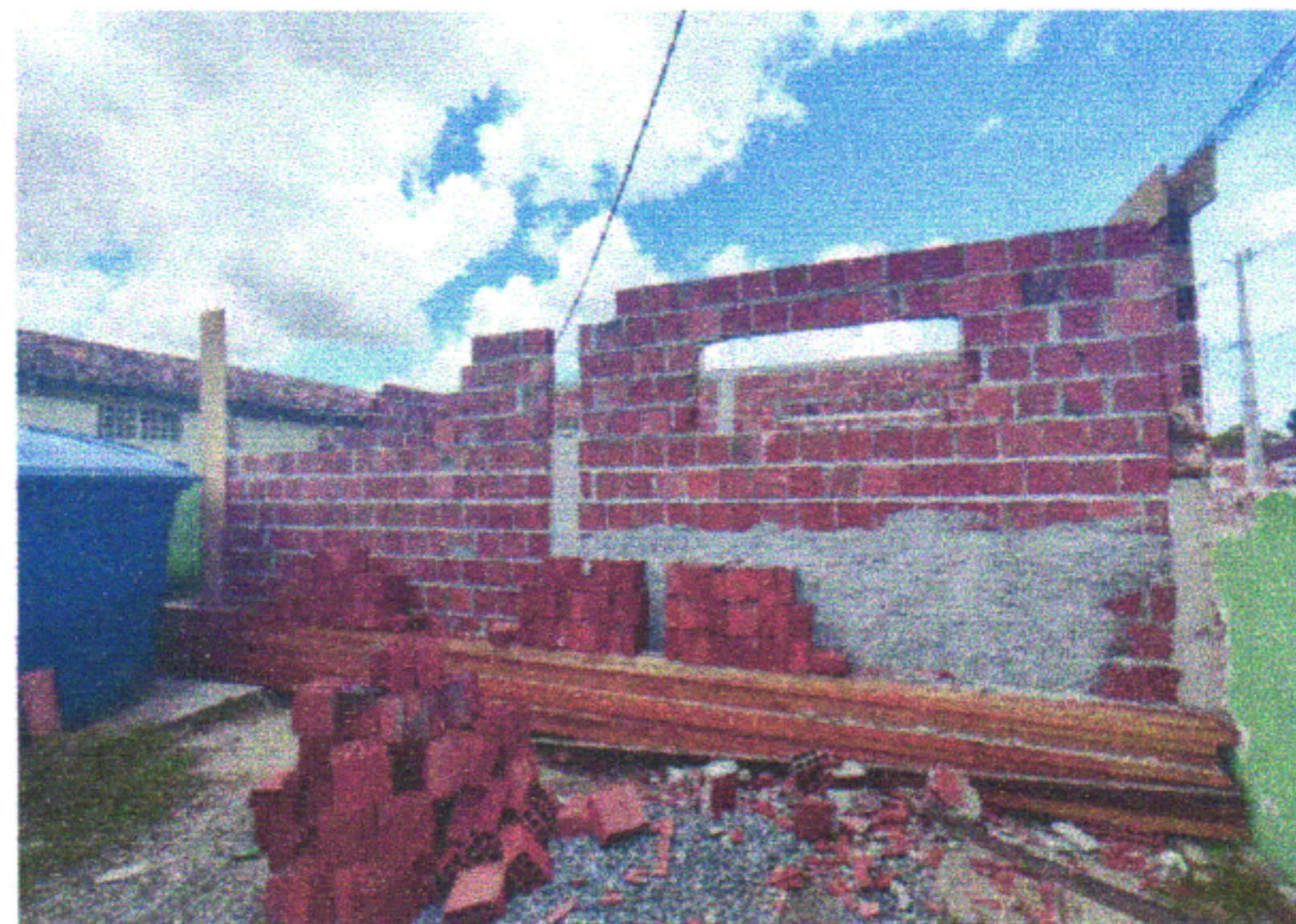
ESCOLA MUNICIPAL JOAQUIM DE BRITO - ALVENARIA
