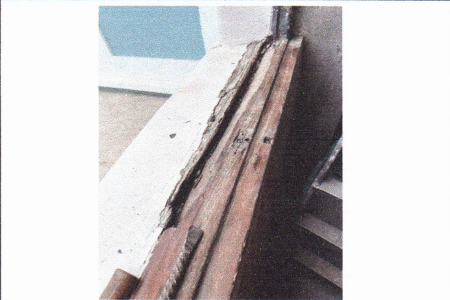
RECUPERAÇÃO DE BATENTE EM MADEIRA NAS JANELAS (PREFEITURA SEDE)
