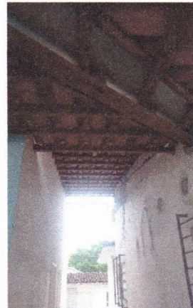
TRAMA DE MADEIRA COMPOSTA POR TERÇAS E CAIBROS, TELHAMENTO COM TELHA CERÂMICA TIPO AMERICANA (ANEXO FUNDOS)
