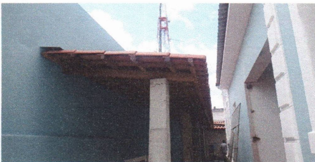
TRAMA DE MADEIRA COMPOSTA POR TERÇAS E CAIBROS, TELHAMENTO COM TELHA CERÂMICA TIPO AMERICANA (ANEXO FUNDOS)
