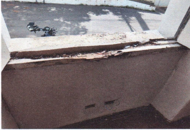
ANTES DA RECUPERAÇÃO DE BATENTE EM MADEIRA NAS JANELAS (PREFEITURA SEDE)
