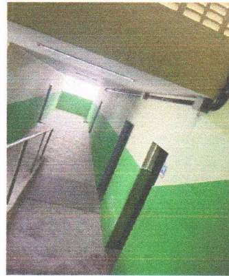
ESCOLA MUNICIPAL APOLÔNIO SALES - INFRAESTRUTURA DOS CIRCUITOS
