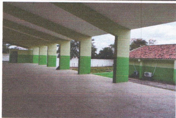
ESCOLA MUNICIPAL APOLÔNIO SALES - PINTURA NO TETO DO PÁTIO
