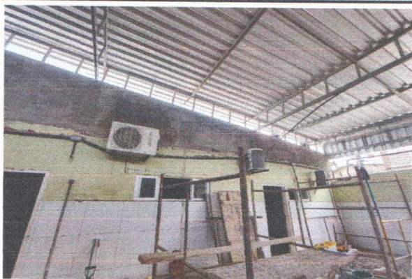
ESCOLA MUNICIPAL CLODOALDO GOMES DE ARAÚJO - ESTRUTURA DE COBERTA METÁLICA TRELIÇADA
