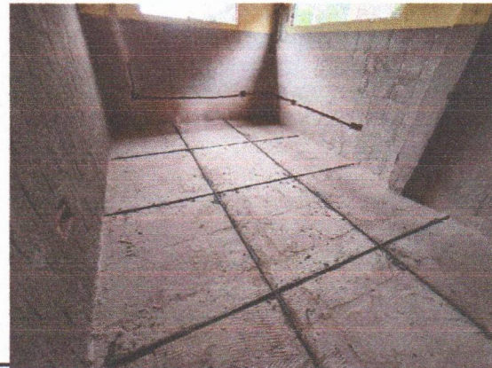
ESCOLA FRANCISCO TAVARES (PISO GRANILITE NO BLOCO A)
