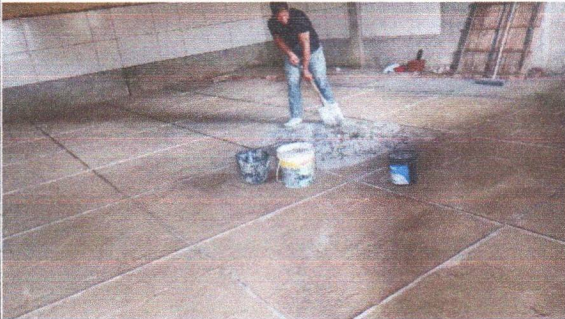
ESCOLA FRANCISCO TAVARES (PISO GRANILITE NO BLOCO A)
