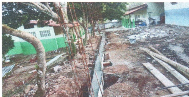
ESCOLA MUNICIPAL FRANCISCO TAVARES - ESCAVAÇÃO
