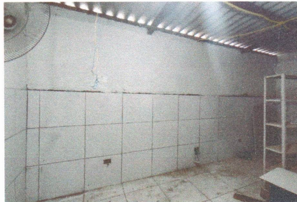
ESCOLA MUNICIPAL CLODOALDO GOMES DE ARAÚJO - REVESTIMENTO CERÂMICO NAS PAREDES
