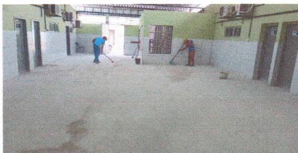
ESCOLA MUNICIPAL CLODOALDO GOMES DE ARAÚJO - PISO GRANILITE NO PÁTIO
