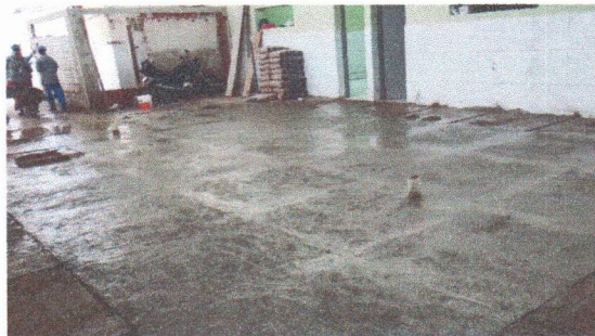
ESCOLA MUNICIPAL CLODOALDO GOMES DE ARAÚJO - PISO GRANILITE NO PÁTIO
