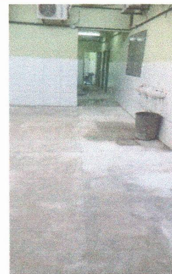
ESCOLA MUNICIPAL CLODOALDO GOMES DE ARAÚJO - PISO GRANILITE NO PÁTIO
