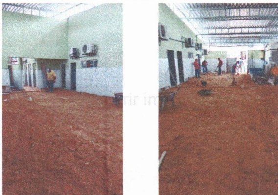
ESCOLA MUNICIPAL CLODOALDO GOMES DE ARAÚJO - ATERRO
