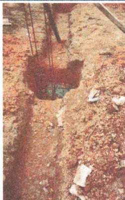
ESCOLA MUNICIPAL FRANCISCO TAVARES - ESCAVAÇÃO
