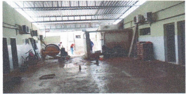
ESCOLA MUNICIPAL CLODOALDO GOMES DE ARAÚJO - PISO GRANILITE NO PÁTIO
