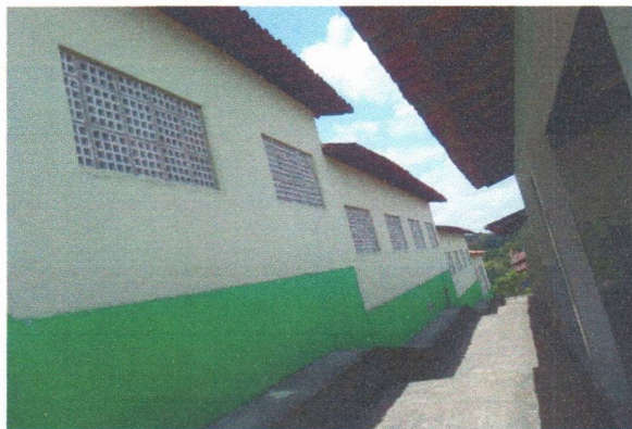
ESCOLA MUNICIPAL TIRADENTES - PINTURA ACRÍLICA NAS PAREDES
