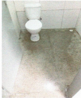
ESCOLA MUNICIPAL FRANCISCO TAVARES - POLIMENTO E RESINA NO PISO
