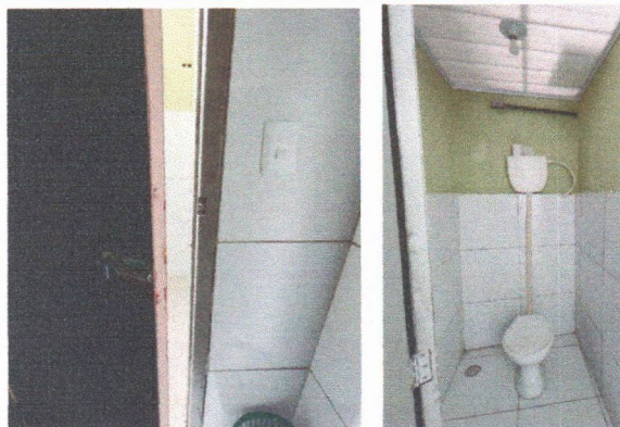
ESCOLA MUNICIPAL CLODOALDO GOMES DE ARAÚJO - PONTO DE ILUMINAÇÃO COM INTERRUPTOR SIMPLES
