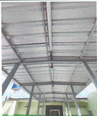
ESCOLA MUNICIPAL INÁCIO GOMES DA SILVA - PONTO DE LUZ E LUMINÁRIAS
