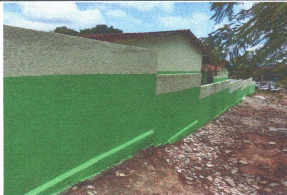
ESCOLA MUNICIPAL FRANCISCO TAVARES - PINTURA ACRILICA NAS PAREDES
