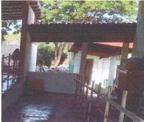
ESCOLA MUNICIPAL FRANCISCO TAVARES - SELADOR, TRAMA E TELHAMENTO
