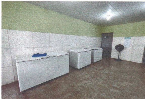
ESCOLA MUNICIPAL FRANCISCO TAVARES - PINTURA NAS PAREDES, FORRO PVC, POLIMENTO E RESINA NO PISO
