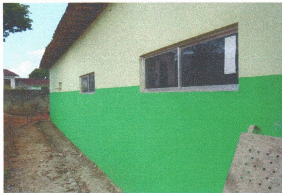
ESCOLA MUNICIPAL FRANCISCO TAVARES - PINTURA ACRILICA NAS PAREDES E JANELAS
