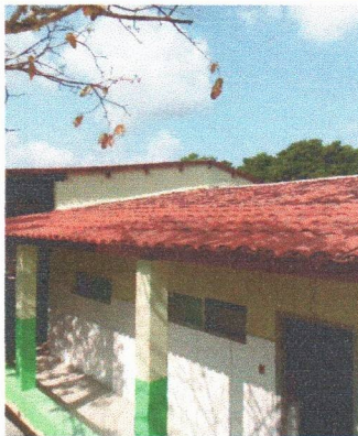
ESCOLA MUNICIPAL FRANCISCO TAVARES - PINTURA NAS PAREDES
