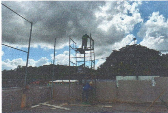
ESCOLA MUNICIPAL ERCINA LAPENDA - ANDAIME PARA INSTALAÇÃO DO ALAMBRADO E DAS TELAS
