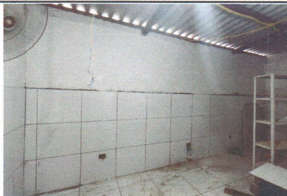
ESCOLA MUNICIPAL CLODOALDO GOMES DE ARAÚJO - EMASSAMENTO E APLICAÇÃO DO SELADOR
