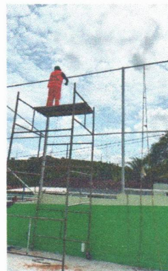
ESCOLA MUNICIPAL ERCINA LAPENDA - ANDAIME PARA INSTALAÇÃO DO ALAMBRADO E DAS TELAS
