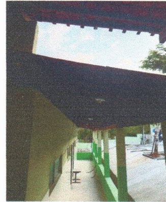
ESCOLA MUNICIPAL FRANCISCO TAVARES - PINTURA NAS PAREDES
