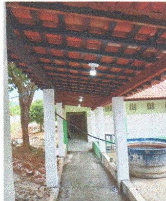
ESCOLA MUNICIPAL FRANCISCO TAVARES - SELADOR, TRAMA E TELHAMENTO
