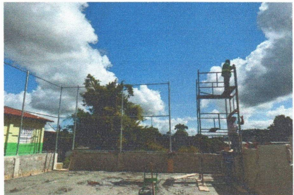
ESCOLA MUNICIPAL ERCINA LAPENDA - ANDAIME PARA INSTALAÇÃO DO ALAMBRADO E DAS TELAS
