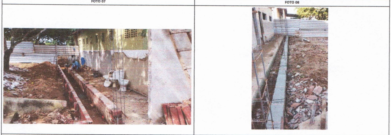
ESCOLA MUNICIPAL FRANCISCO TAVARES - EXECUÇÃO DE PILARES E ALVENARIA ESCOLA MUNICIPAL FRANCISCO TAVARES - EXECUÇÃO DE PILARES, CINTA E ALVENARIA
