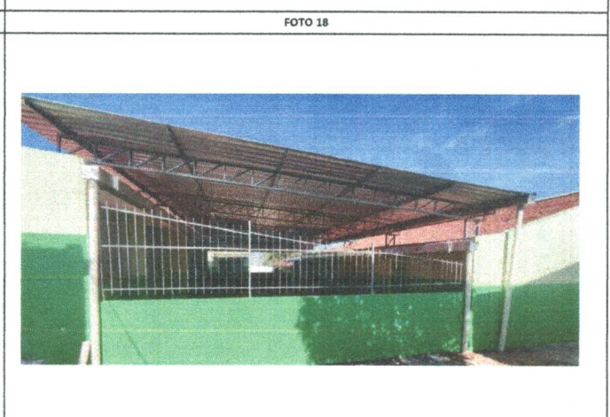
ESCOLA MUNICIPAL APOLÔNIO SALES - ESTRUTURA METÁLICA TRELIÇADA
