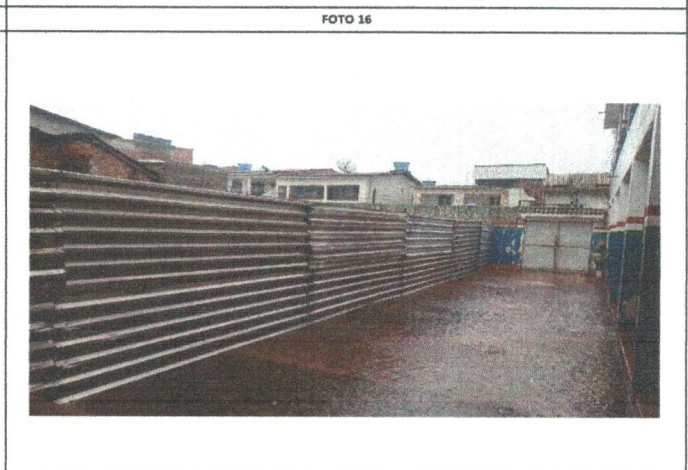
ESCOLA MUNICIPAL MARIA JOSÉ - TAPUME COM TELHA METÁLICA
