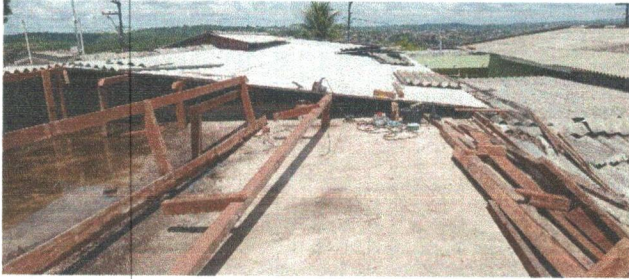
ESCOLA MUNICIPAL INÁCIO GOMES DA SILVA - MADEIRAMENTO PARA TELHA ONDULADA DE FIBROCIMENTO
