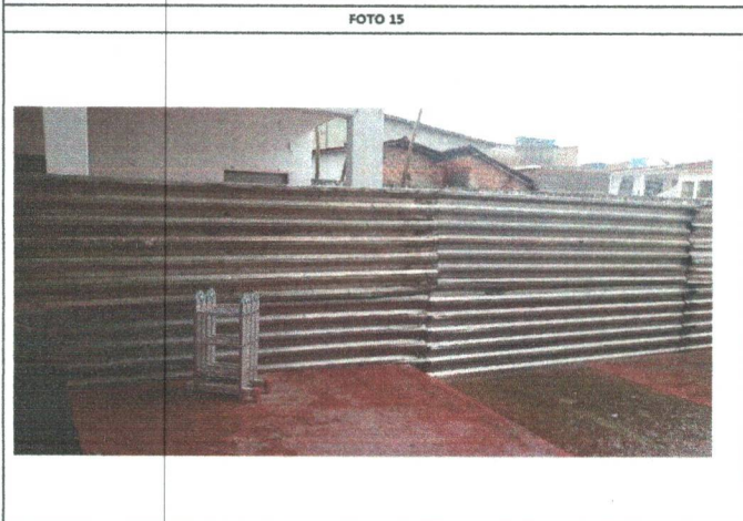
ESCOLA MUNICIPAL MARIA JOSÉ - TAPUME COM TELHA METÁLICA
