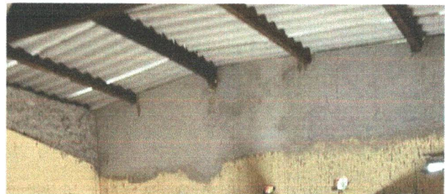
ESCOLA MUNICIPAL SENADOR FRANCISCO GOMES DE ARAÚJO - MADEIRAMENTO PARA TELHA ONDULADA DE FIBROCIMENTO
