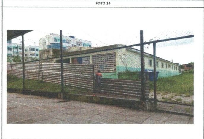
ESCOLA MUNICIPAL ROSINA LABANCA - TAPUME COM TELHA METÁLICA
