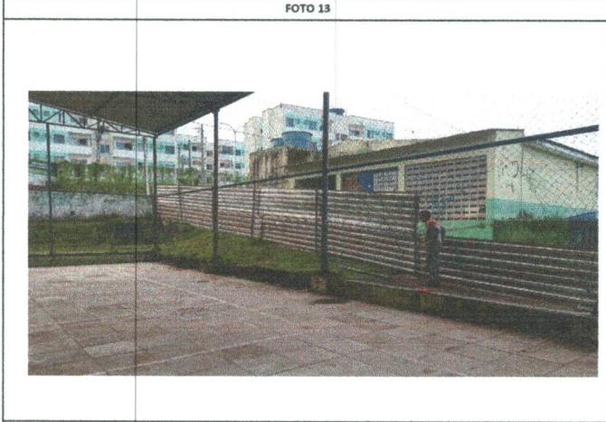
ESCOLA MUNICIPAL ROSINA LABANCA - TAPUME COM TELHA METÁLICA
