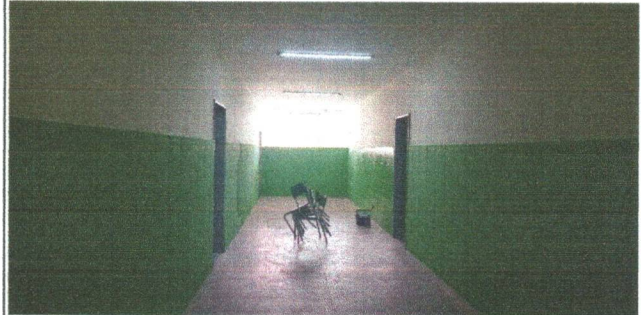
ESCOLA MUNICIPAL APOLÔNIO SALES - PINTURA ACRÍLICA EM TETO
