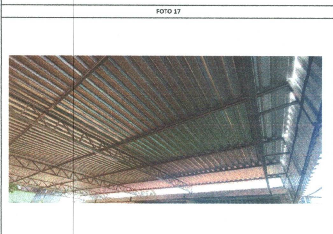
ESCOLA MUNICIPAL APOLÔNIO SALES - ESTRUTURA METÁLICA TRELIÇADA
