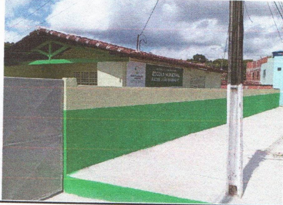
ESCOLA MUNICIPAL PADRE JOÃO BARBALHO - PINTURA DE PAREDES E PINTURA DE ESQUADRIA METÁLICA
