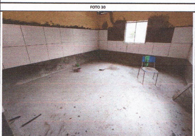
ESCOLA MUNICIPAL SENADOR FRANCISCO GOMES DE ARAÚJO - REVESTIMENTO CERÂMICO E PISO GRANILITE
