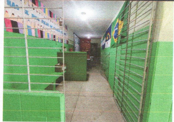
ESCOLA MUNICIPAL PADRE JOÃO BARBALHO - PINTURA DE PAREDES E PINTURA DE ESQUADRIA METÁLICA
