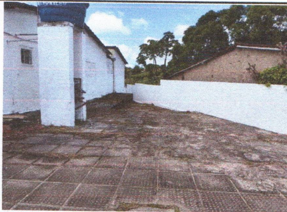
ESCOLA MUNICIPAL PADRE JOÃO BARBALHO - PINTURA DE PAREDES
