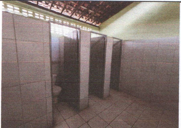
ESCOLA MUNICIPAL PADRE JOÃO BARBALHO - PINTURA DE PAREDES E PINTURA DE ESQUADRIA DE MADEIRA
