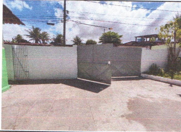
ESCOLA MUNICIPAL PADRE JOÃO BARBALHO - PINTURA DE PAREDES E PINTURA DE ESQUADRIA METÁLICA
