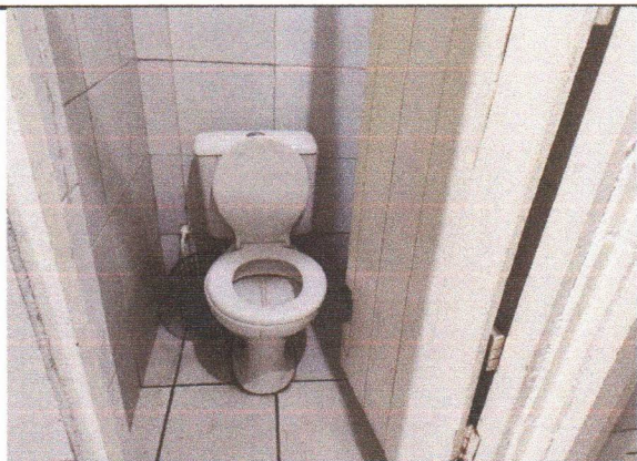
ESCOLA MUNICIPAL PADRE JOÃO BARBALHO - INSTALAÇÃO DE LOUÇA SANITÁRIA E ACESSÓRIOS
