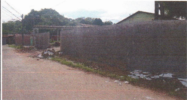
ESCOLA MUNICIPAL ERCINA LAPENDA - REVESTIMENTO COM CHAPISCO E MASSA ÚNICA
