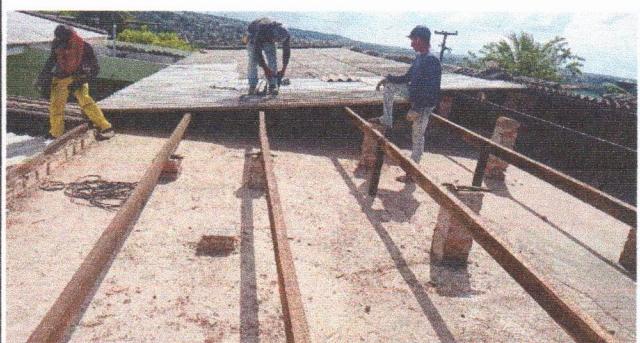
ESCOLA MUNICIPAL INÁCIO GOMES DA SILVA - REMOÇÃO DE TELHA FIBROCIMENTO
