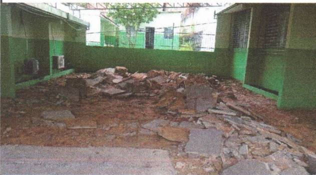
ESCOLA MUNICIPAL APOLÔNIO SALES - DEMOLIÇÃO DE PISO EM LAJOTA
