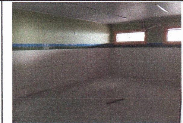
PINTURA LÁTEX ACRÍLICA STANDARD, APLICAÇÃO MANUAL EM PAREDES
