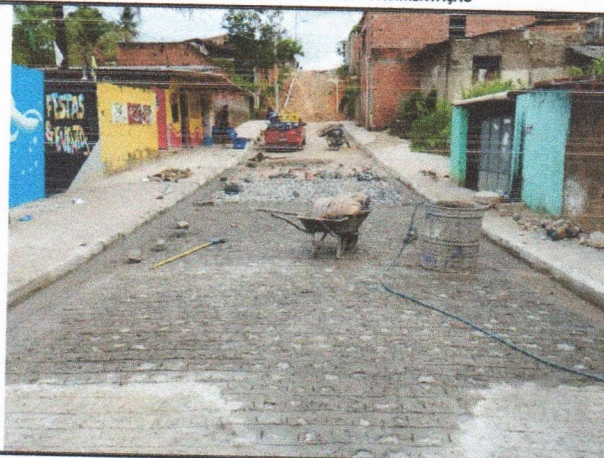
RUA BELÉM DE SÃO FRANCISCO - PAVIMENTAÇÃO
