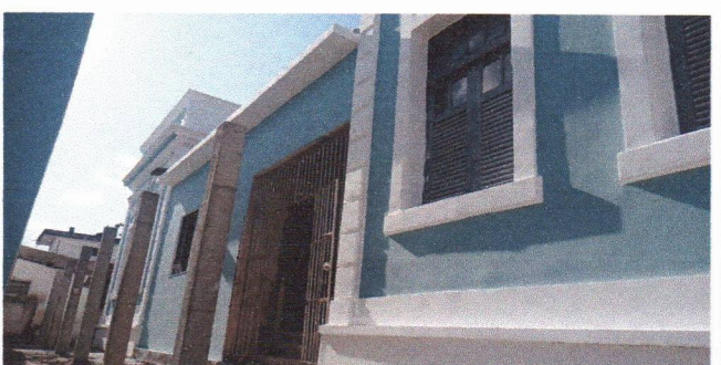
RASPAGEM DA PINTURA (ANEXO FUNDOS)
