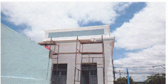
MASSA ACRÍLICA NA FACHADO E APLICAÇÃO DE SELADOR (PREFEITURA SEDE)
