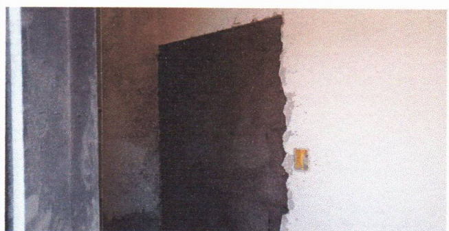
ALVENARIA E CHAPISCO NOS FECHAMENTOS DAS PORTAS (PREFEITURA SEDE)
