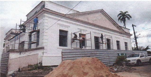
MASSA ACRÍLICA NA FACHADO E APLICAÇÃO DE SELADOR (PREFEITURA SEDE)
