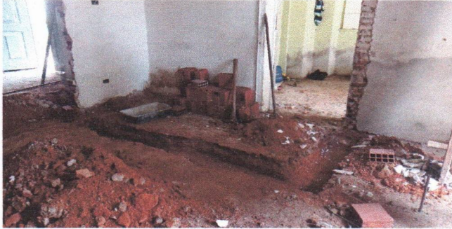
ESCAVAÇÃO PARA A ALVENARIA DO ACESSO A SALA 01 (PREFEITURA SEDE)
