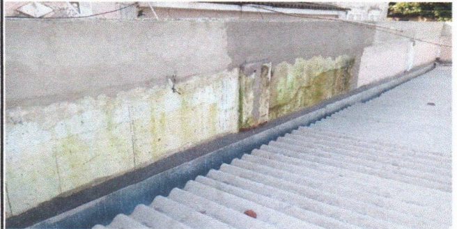
INSTALAÇÃO DA CALHA NO ANEXO DOS FUNDOS (ANEXO FUNDOS)
