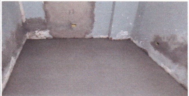
CONTRAPISO (ANEXO FUNDOS)
