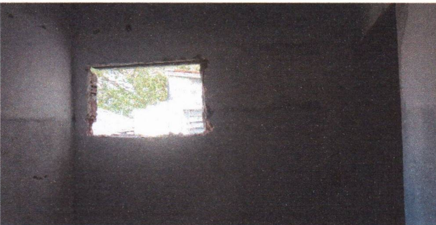
REMOÇÃO DE JANELAS (ANEXO FUNDOS)
