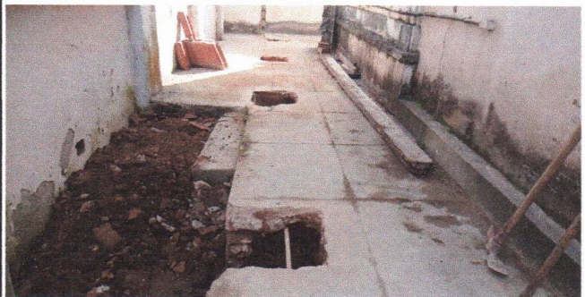
ESCAVAÇÃO (ANEXO FUNDOS)
