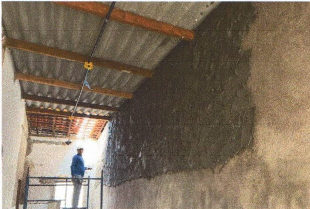
TELHAMENTO, TRAMA, APLICAÇÃO DO CHAPISCO, EMBOÇO, MASSA ÚNICA NAS PAREDES E INSTALAÇÃO DE PONTOS ELÉTRICOS
