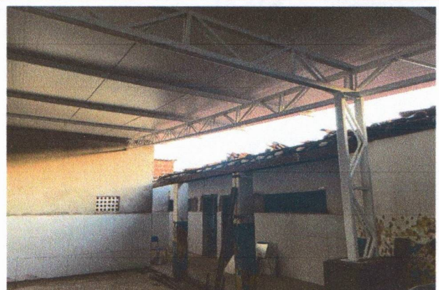
UTILIZAÇÃO DE ANDAIME PARA O TELHAMENTO E ESTRUTURA METÁLICA, APLICAÇÃO DO EMBOÇO E REVESTIMENTO CERÂMICO EM PAREDES
