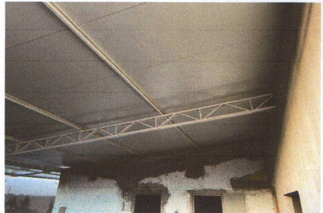
UTILIZAÇÃO DE ANDAIME PARA O TELHAMENTO E ESTRUTURA METÁLICA
