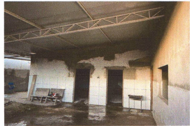
APLICAÇÃO DO CHAPISCO, EMBOÇO E REVESTIMENTO CERÂMICO NAS PAREDES
