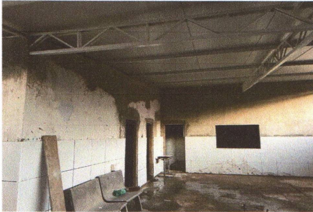
UTILIZAÇÃO DE ANDAIME PARA O TELHAMENTO E ESTRUTURA METÁLICA, APLICAÇÃO DO EMBOÇO E REVESTIMENTO CERÂMICO EM PAREDES
