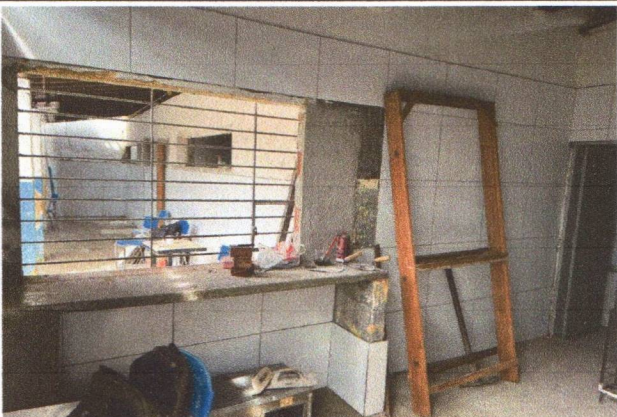
APLICAÇÃO REVESTIMENTO CERÂMICO NAS PAREDES
