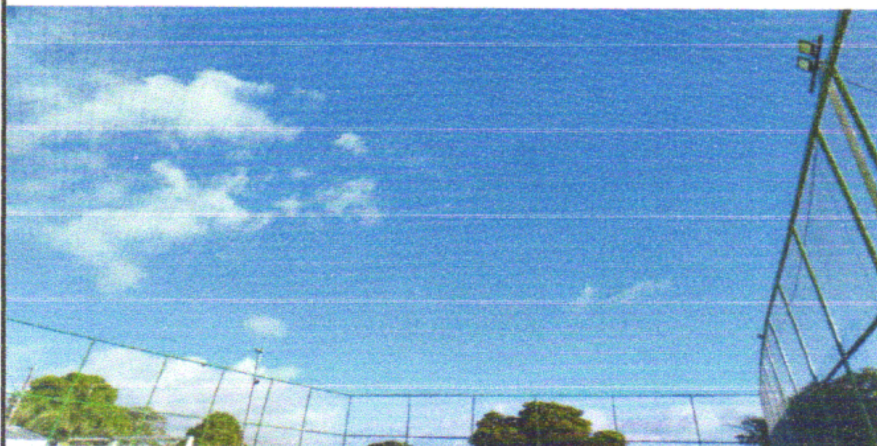
COLOCAÇÃO DA TELA EM NYLON, FIXAÇÃO COM CABOS DE AÇO E ESTICADORES NA PARTE SUPERIOR NA QUADRA
