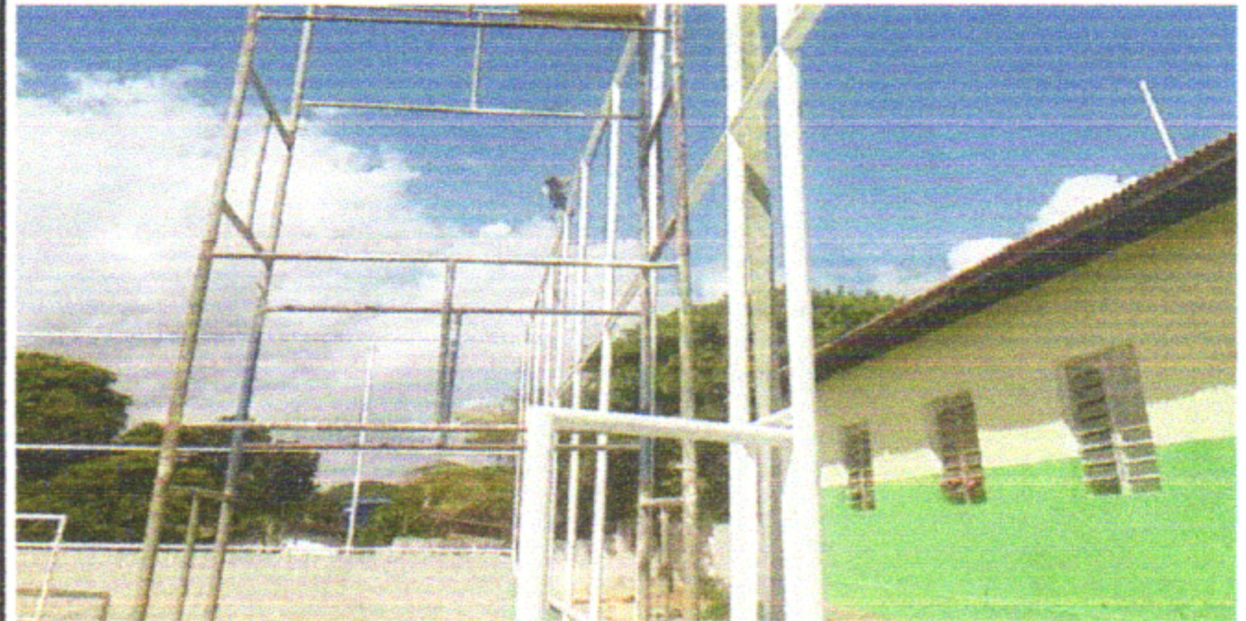
UTILIZAÇÃO DE ANDAIME PARA A COLOCAÇÃO DA TELA DE NYLON SUPERIOR
