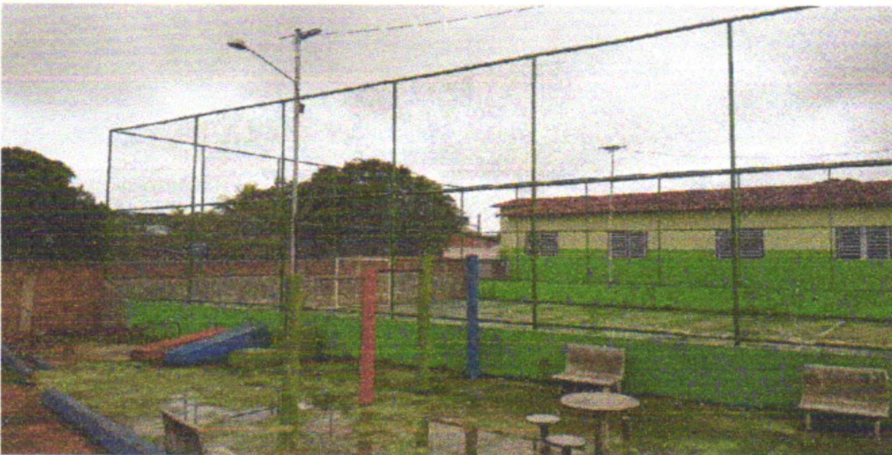
PINTURA ESMALTE DO ALAMBRADO E COLOCAÇÃO DAS TELAS GALVANIZADA NAS LATERAIS DA QUADRA
