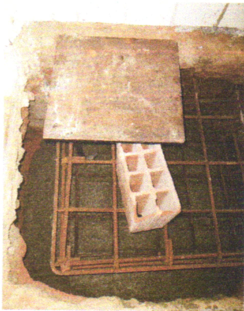
ARMADURA DE AÇO CA 50/60
