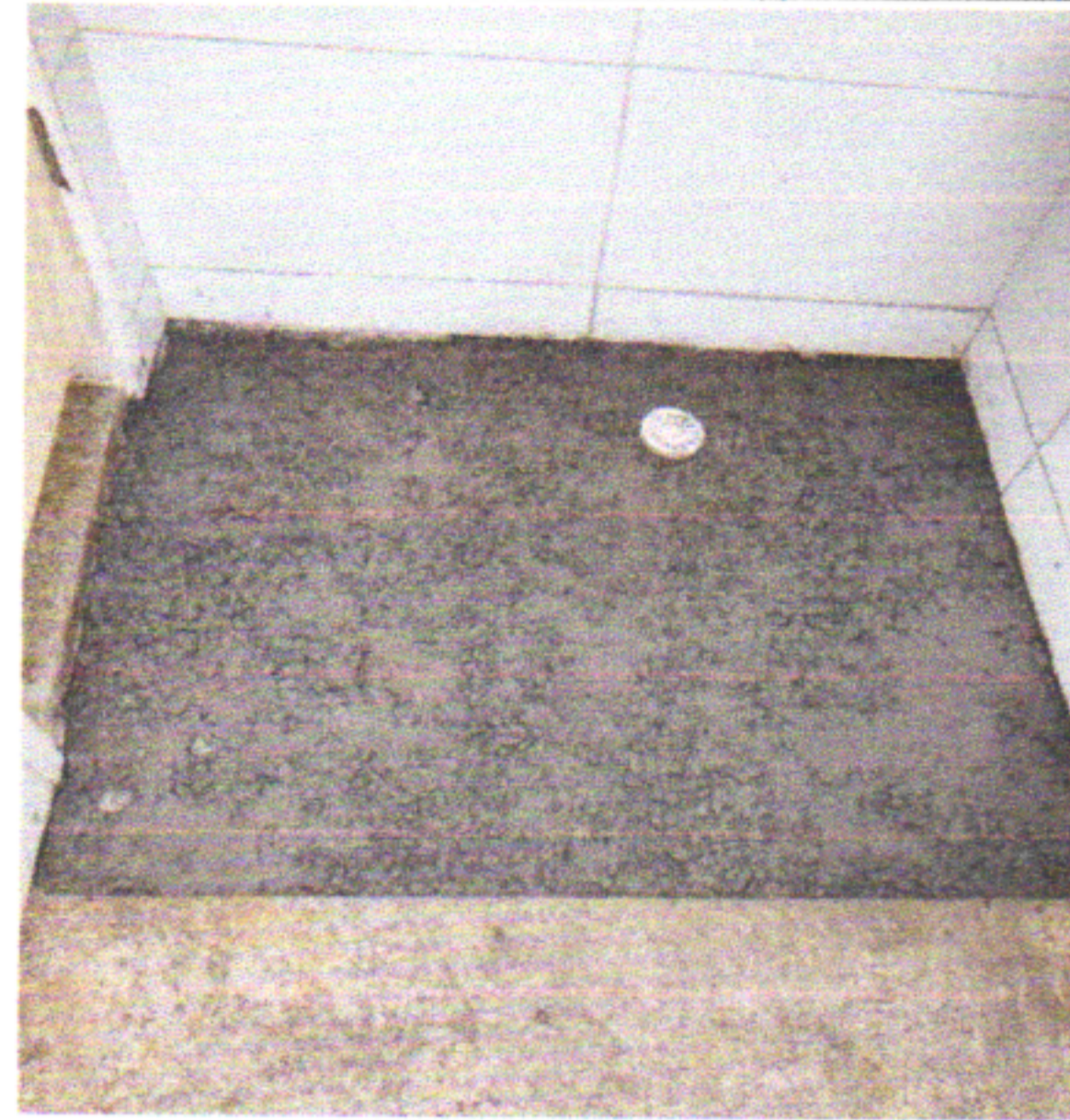
LASTRO DE CONCRETO MAGRO
