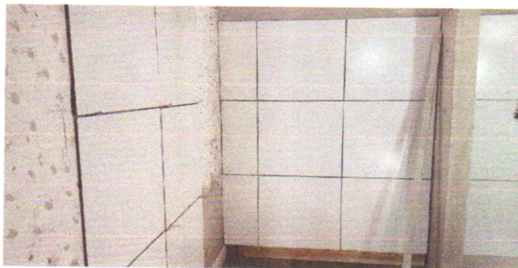
REVESTIMENTO CERÂMICO EM PAREDES NO WC MASCULINO
