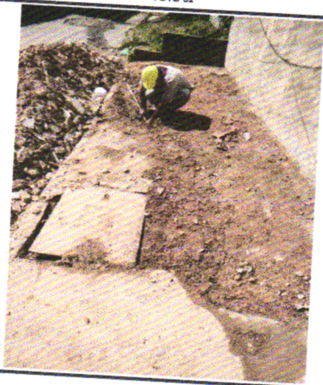
DEMOLIÇÃO DE CONCRETO
