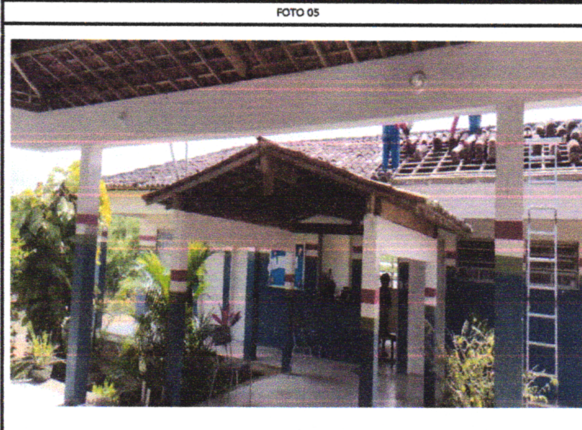
RETIRADA E RECOLOCAÇÃO DE TELHA CERÂMICA CAPA CANAL
