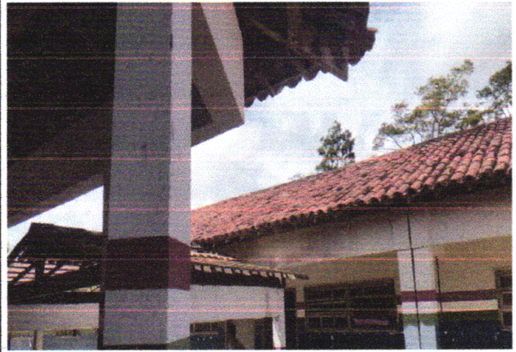
RETIRADA E RECOLOCAÇÃO DE TELHA CERÂMICA CAPA CANAL
