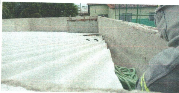
TRAMA E TELHAMENTO COM TELHA ONDULADA DE FIBROCIMENTO
