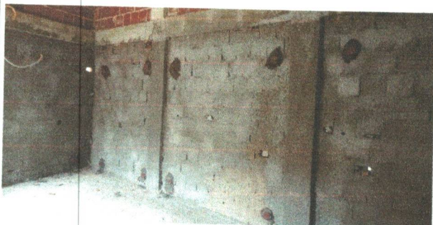
APLICAÇÃO DO CHAPISCO NAS PAREDES
