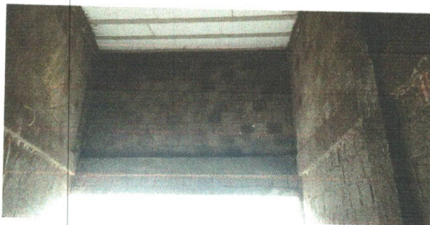
APLICAÇÃO DO CHAPISCO NAS PAREDES
