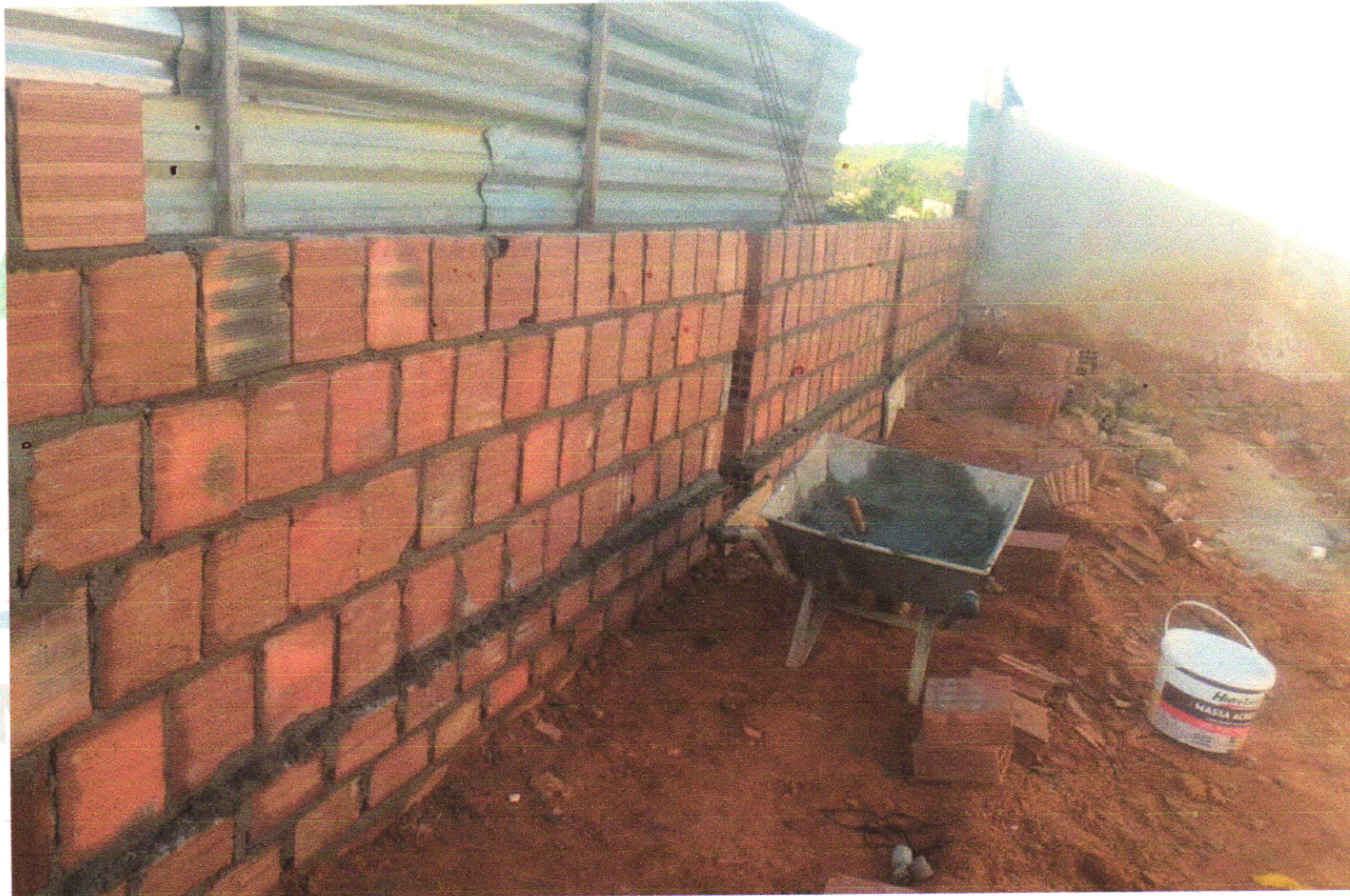
FOTO 15 (ELEVAÇÃO DA ALVENARIA – MURO FRONTAL)
