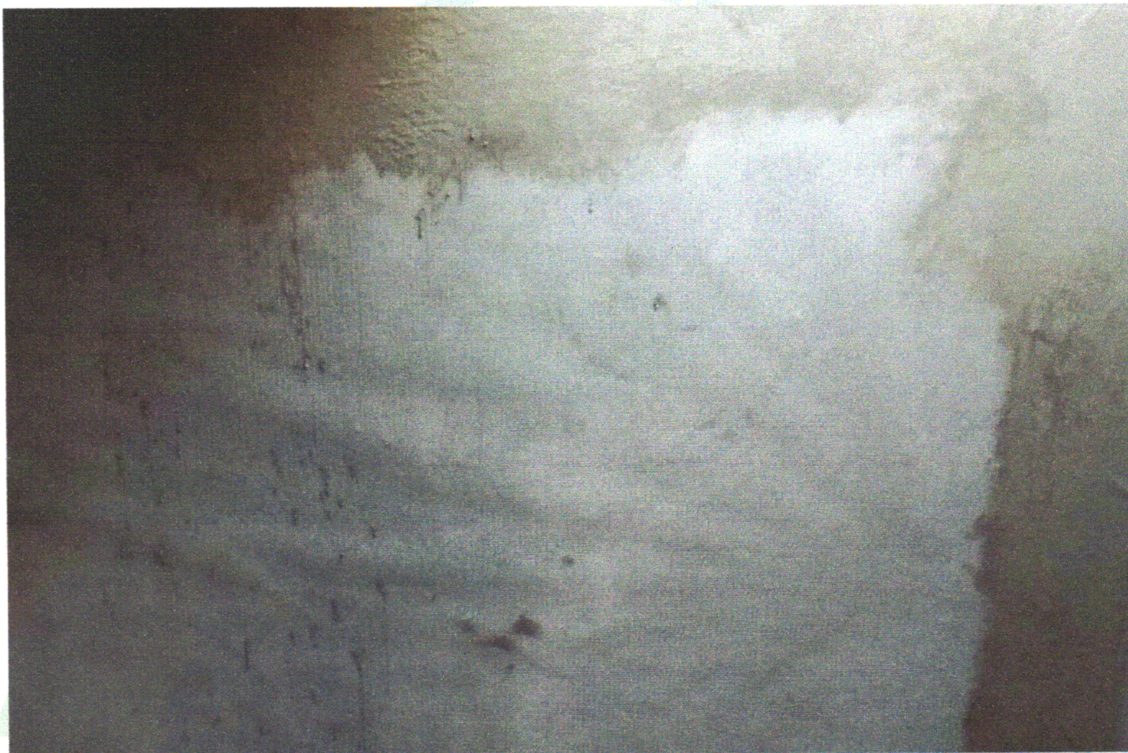
FOTO 01 (IMPERMEABILIZAÇÃO RESERVATÓRIO INFERIOR)
