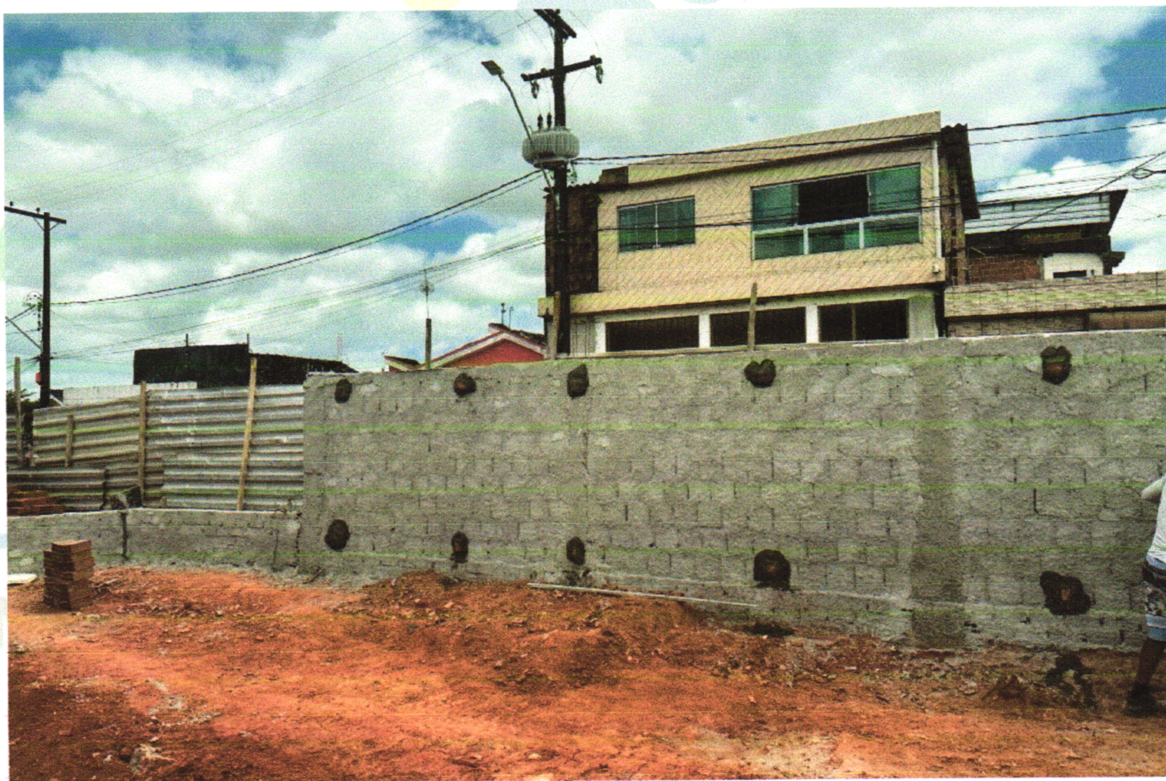
FOTO 17 (ELEVAÇÃO DA ALVENARIA – MURO FRONTAL)
