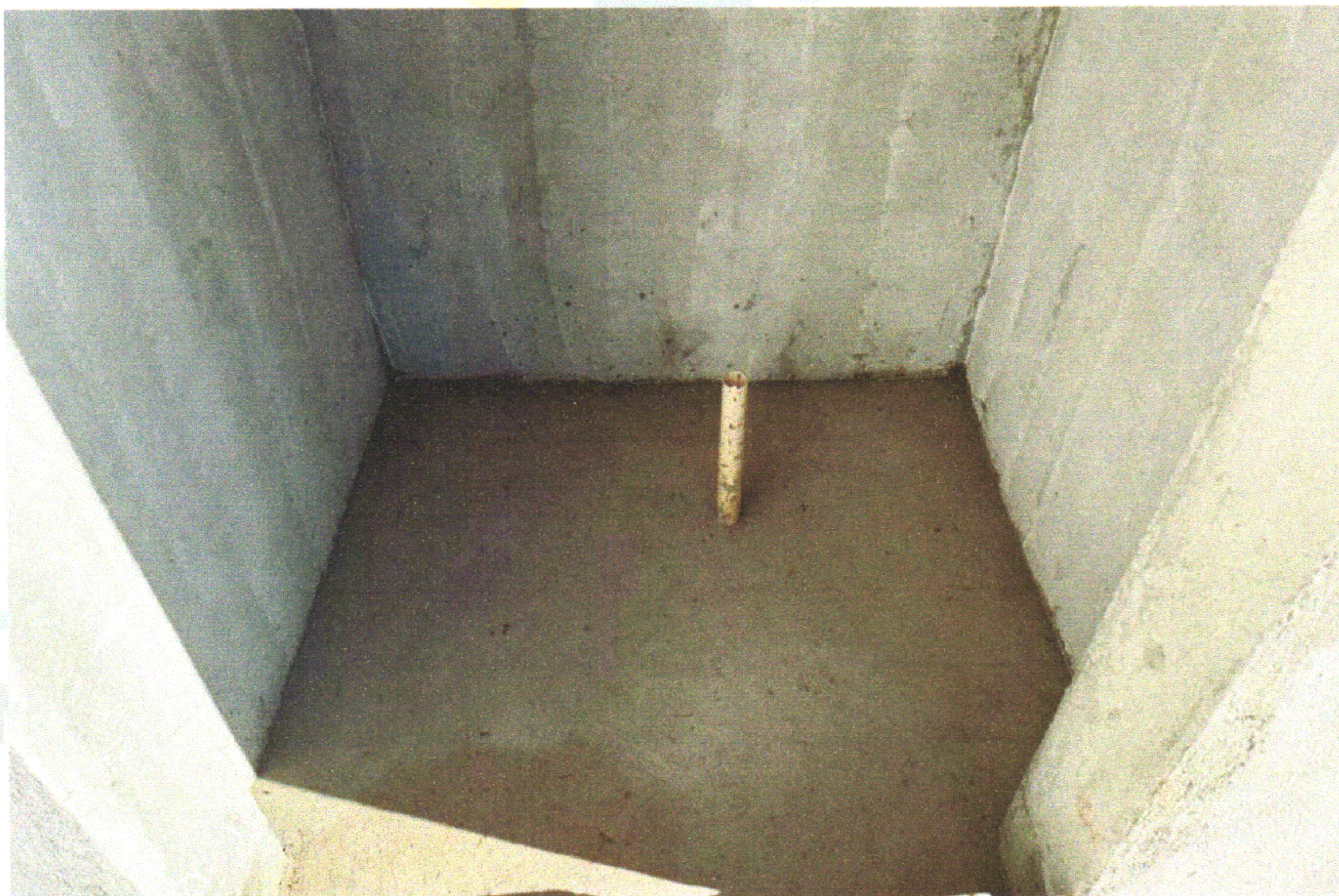
FOTO 13 (EXECUÇÃO DE CONTRAPISO DO ABRIDO DE RESÍDUOS)
