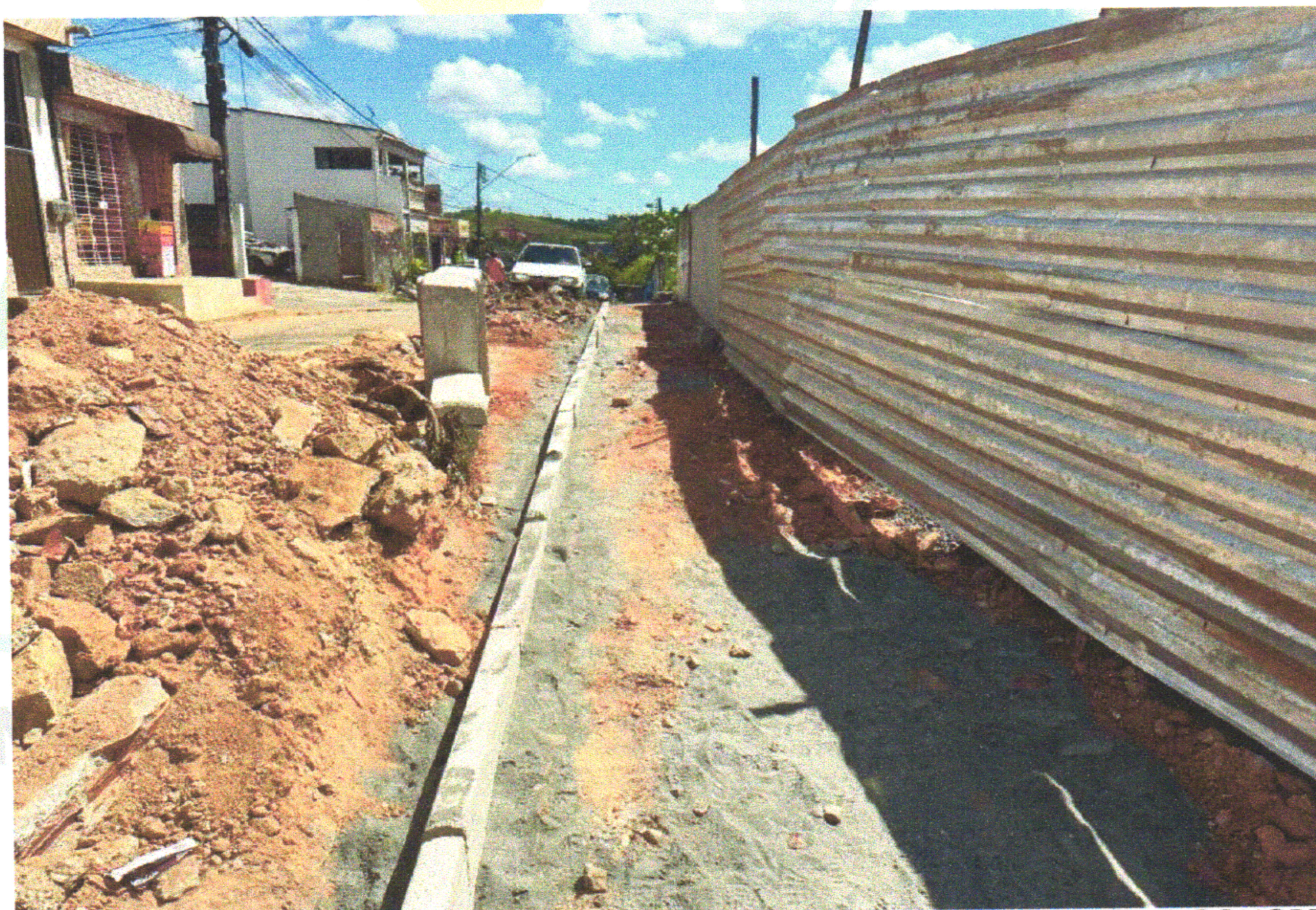
FOTO 03 (DEMOLIÇÃO DE MEIO-FIO GRANITICO E ASSENTAMENTO DE MEIO-FIO DE CONCRETO)
