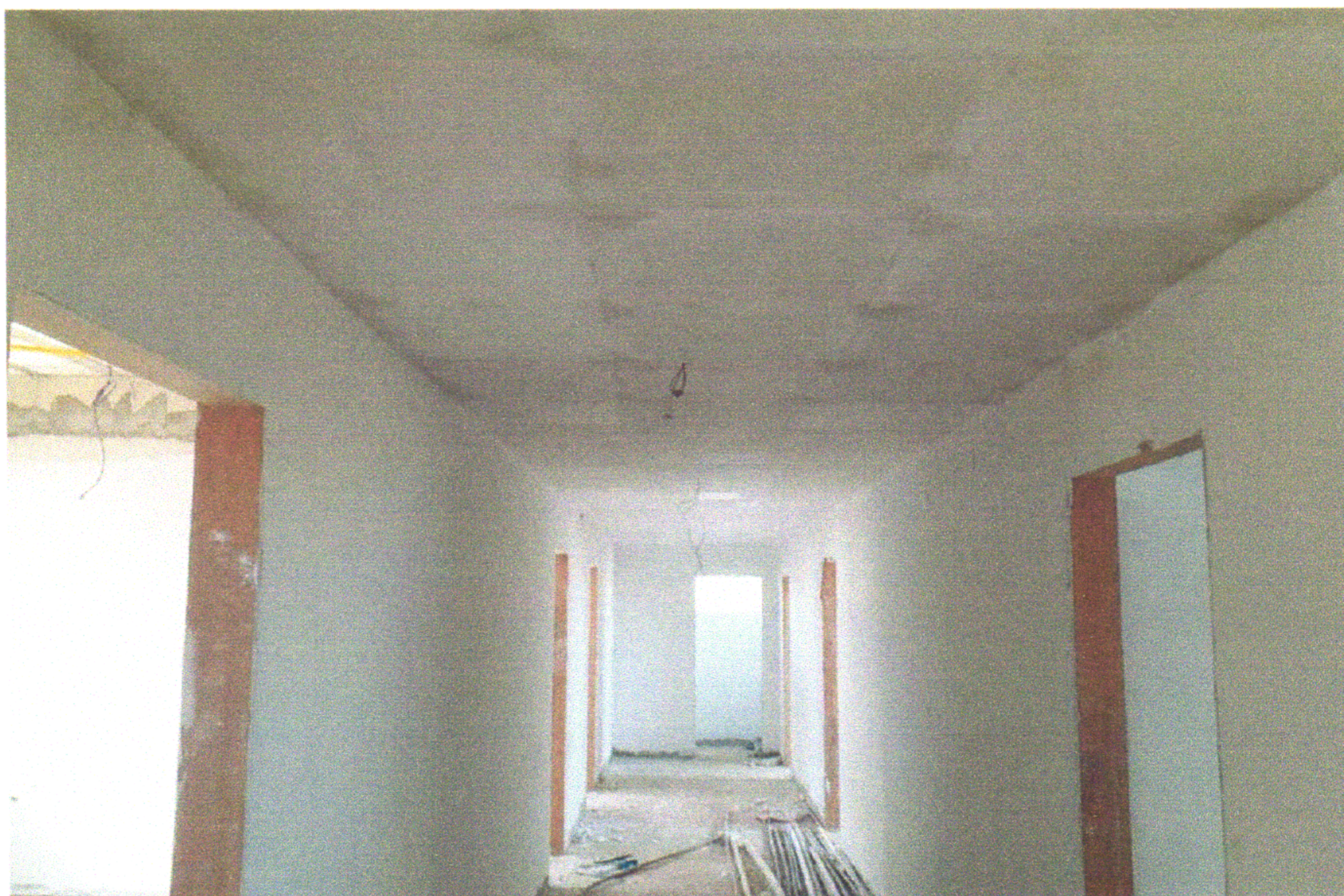
FOTO 10 (EXECUÇÃO DE FORRO DE GESSO)
