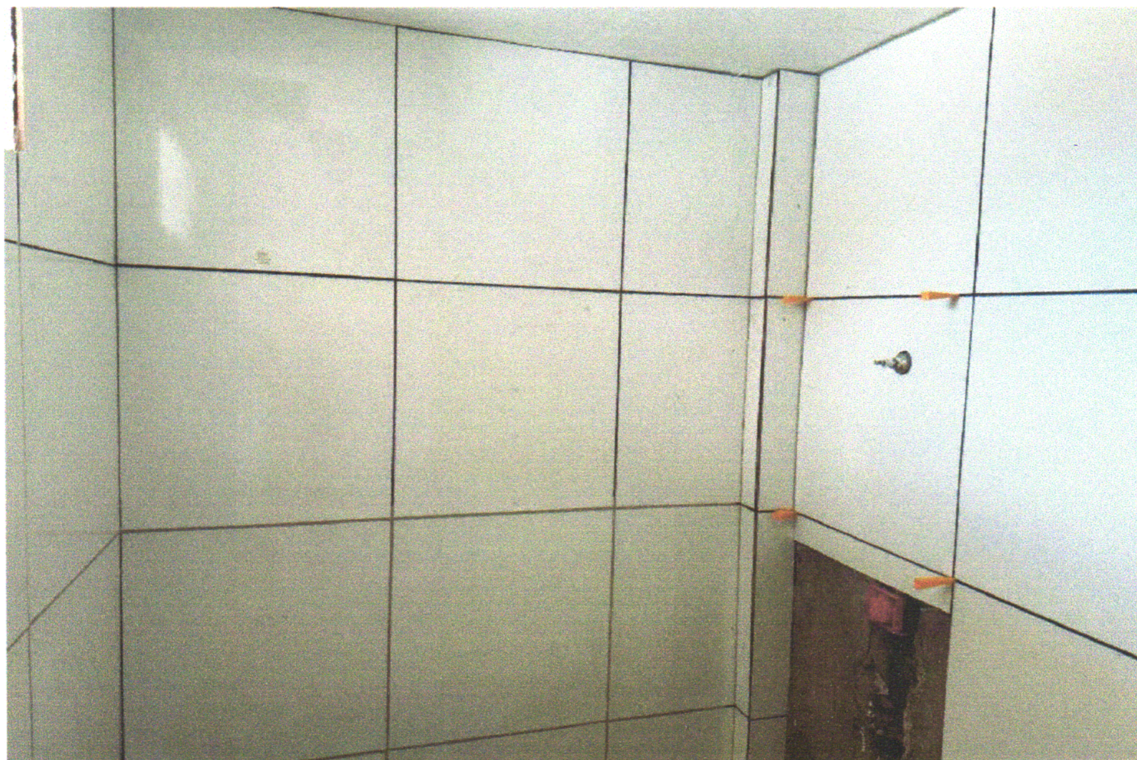
FOTO 06 (REVESTIMENTO CERÂMICO PARA PAREDE COM PLACAS DE DIMENSÕES 60X60 CM)
