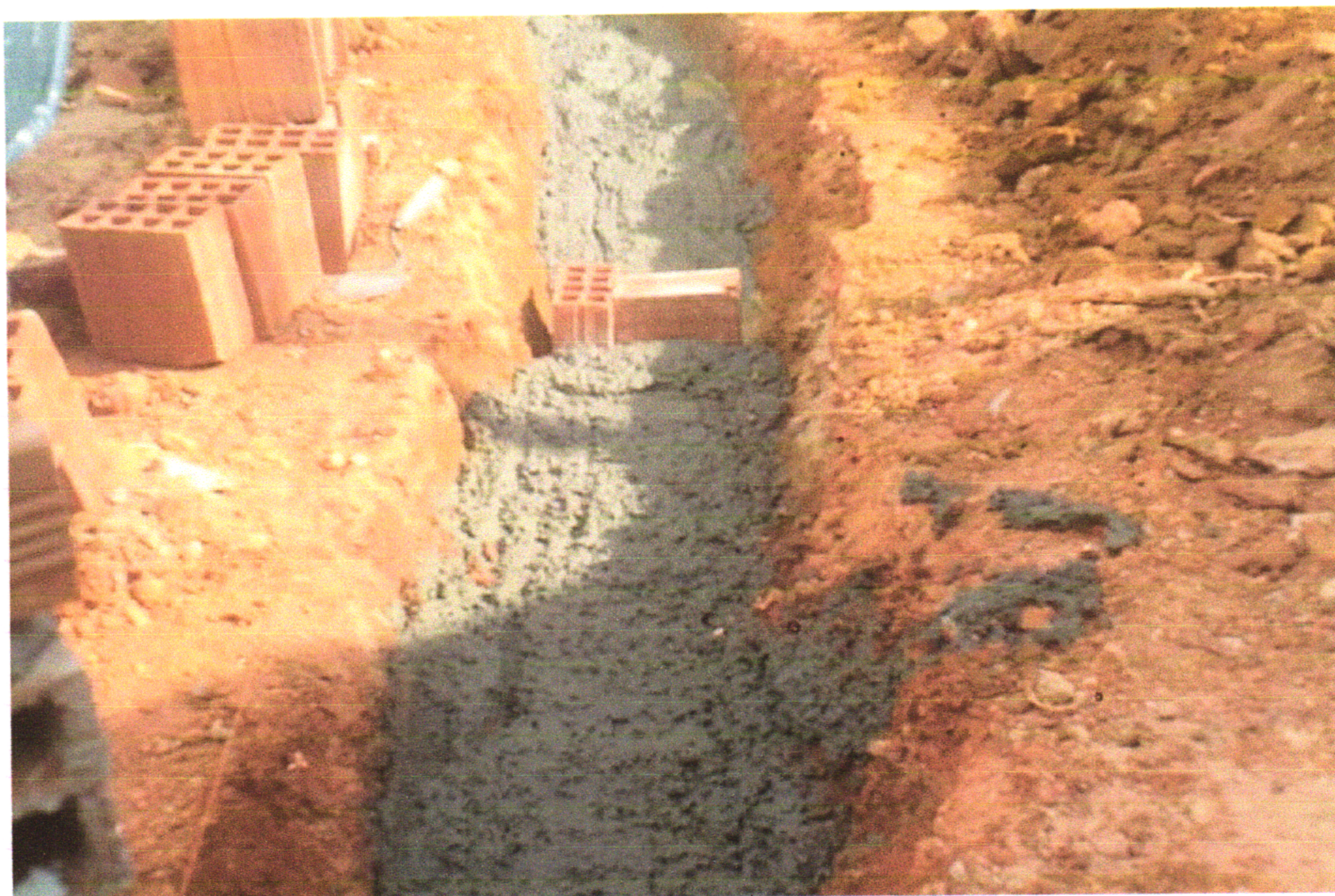
FOTO 14 (LASTRO DE CONCRETO – MURO FRONTAL)
