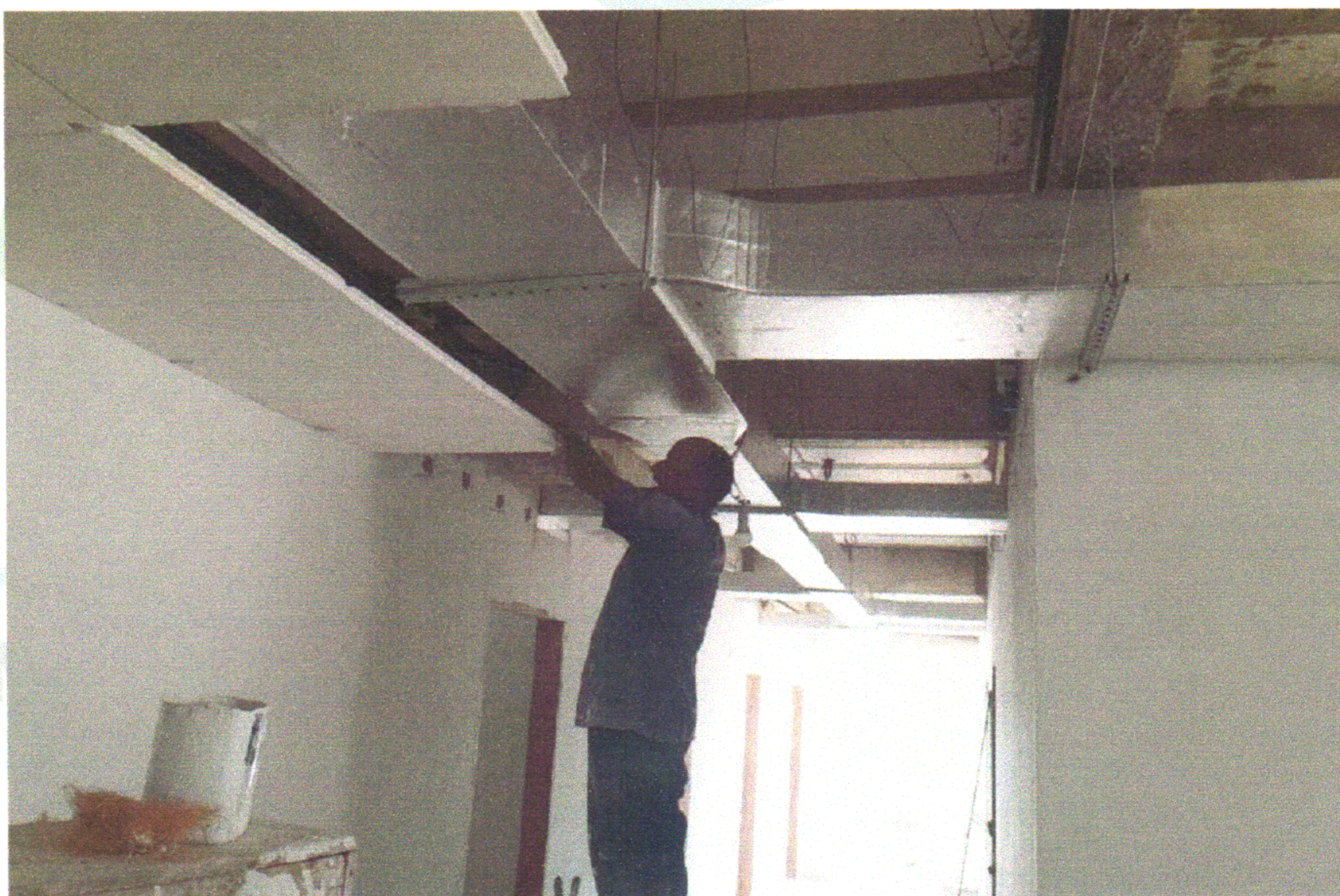
FOTO 09 (EXXECUÇÃO DE FORRO DE GESSO)
