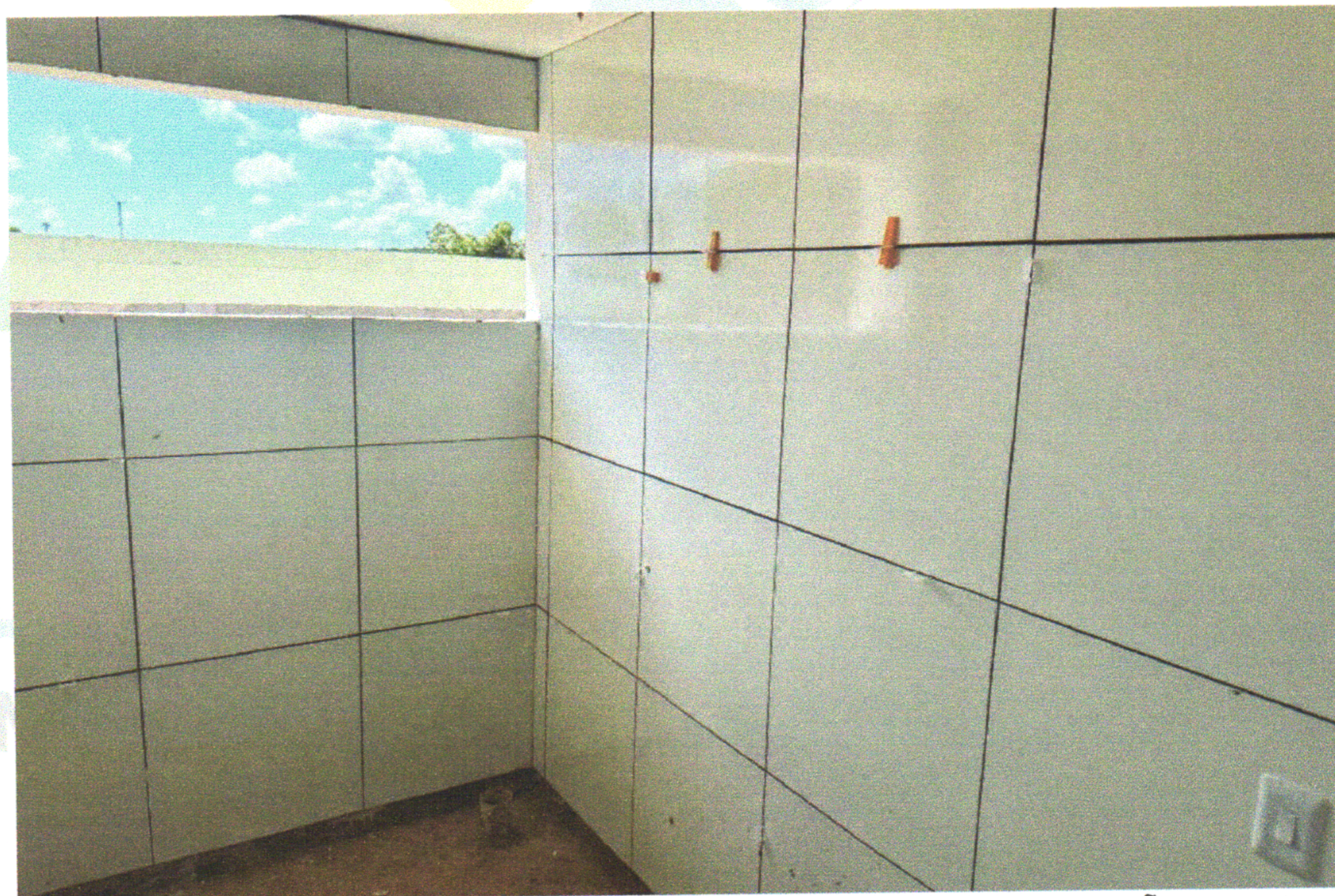
FOTO 05 (REVESTIMENTO CERÂMICO PARA PAREDE COM PLACAS DE DIMENSÕES 60X60 CM)
