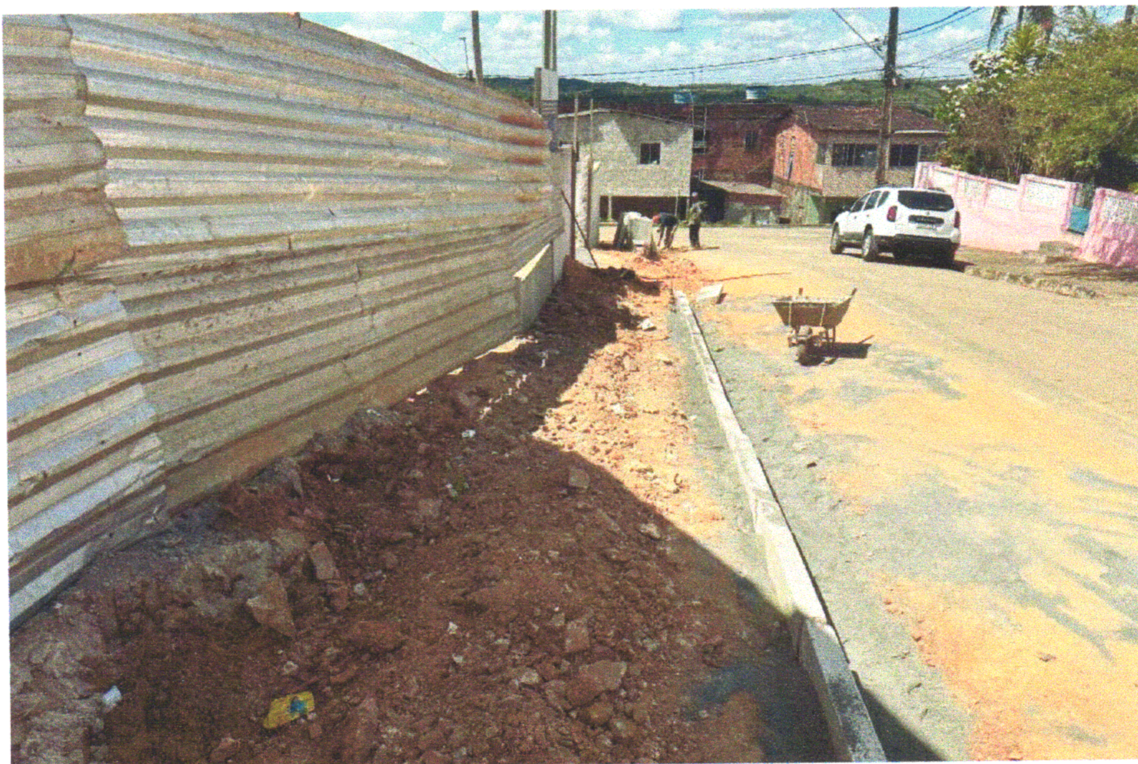
FOTO 04 (DEMOLIÇÃO DE MEIO-FIO GRANITICO E ASSENTAMENTO DE MEIO-FIO DE CONCRETO)
