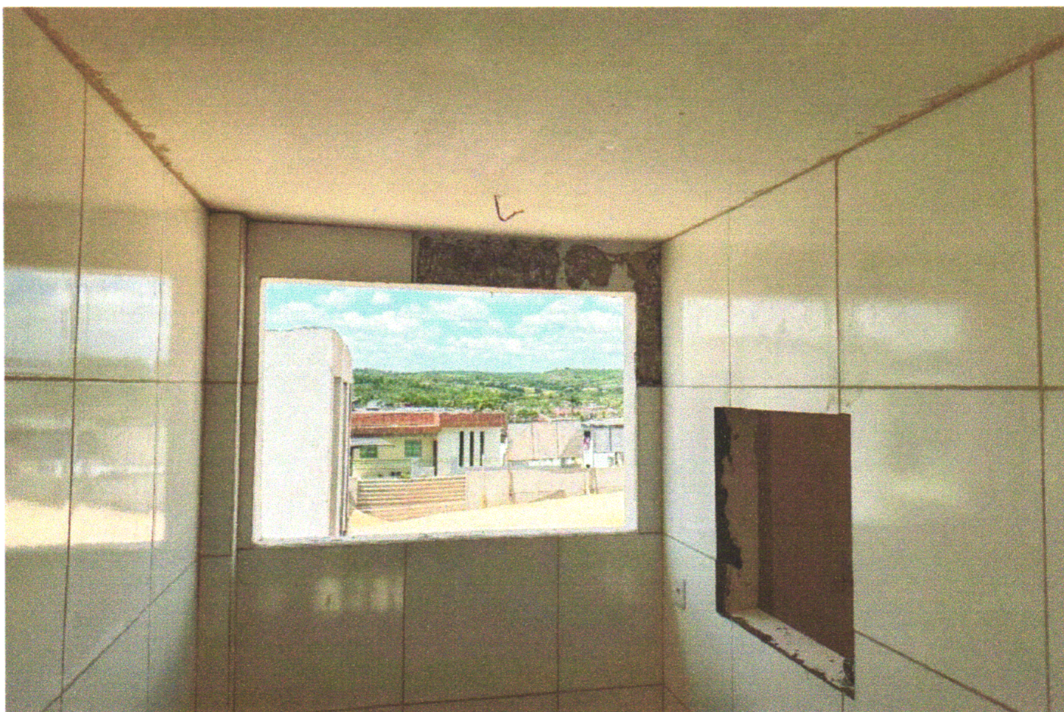
FOTO 08 (REVESTIMENTO CERÂMICO PARA PAREDE COM PLACAS DE DIMENSÕES 60X60 CM E FORRO DE GESSO)
