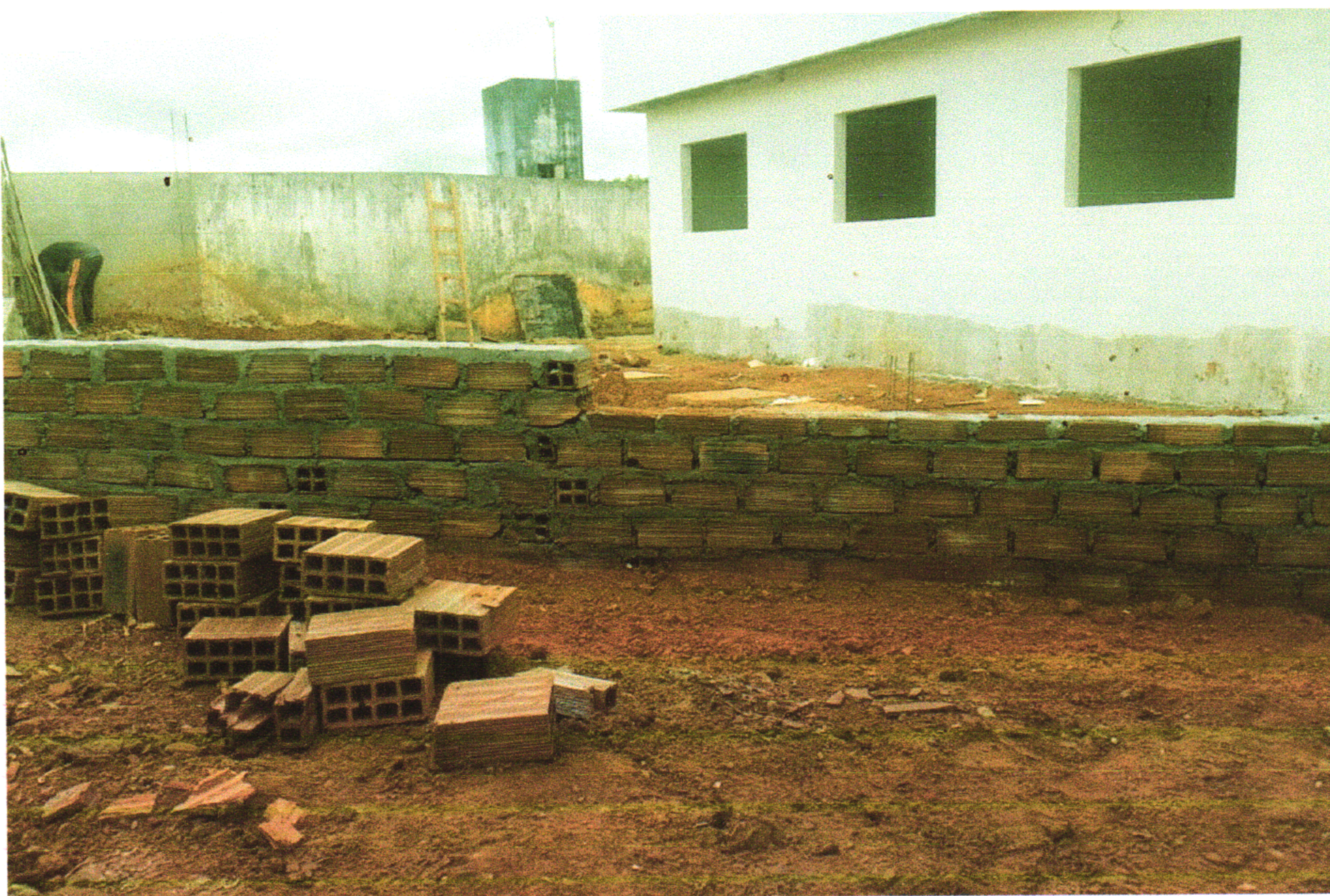
FOTO 16 (ELEVAÇÃO DA MURETA FRONTAL)
