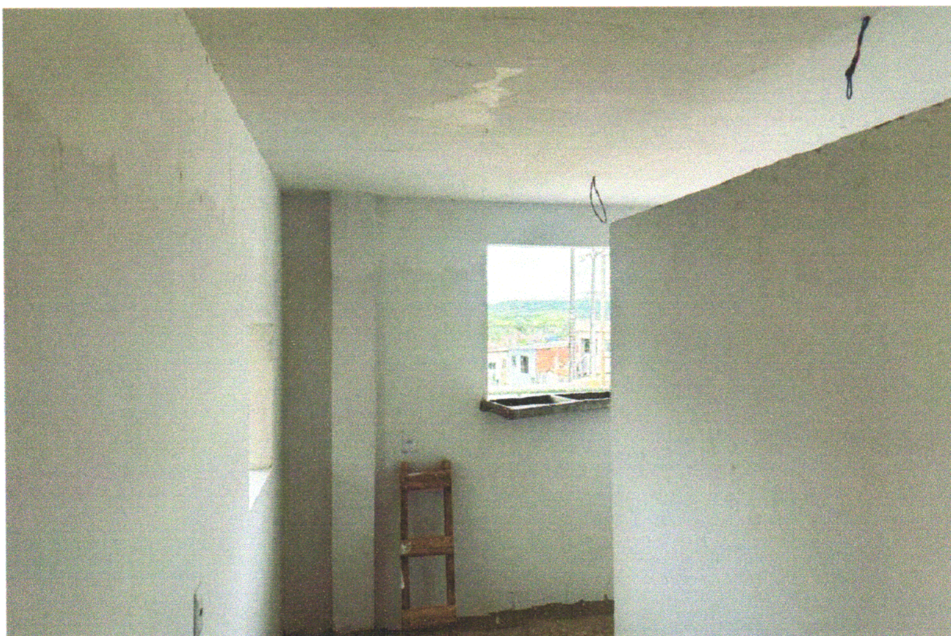
FOTO 12 (EXECUÇÃO DE FORRO DE GESSO)
