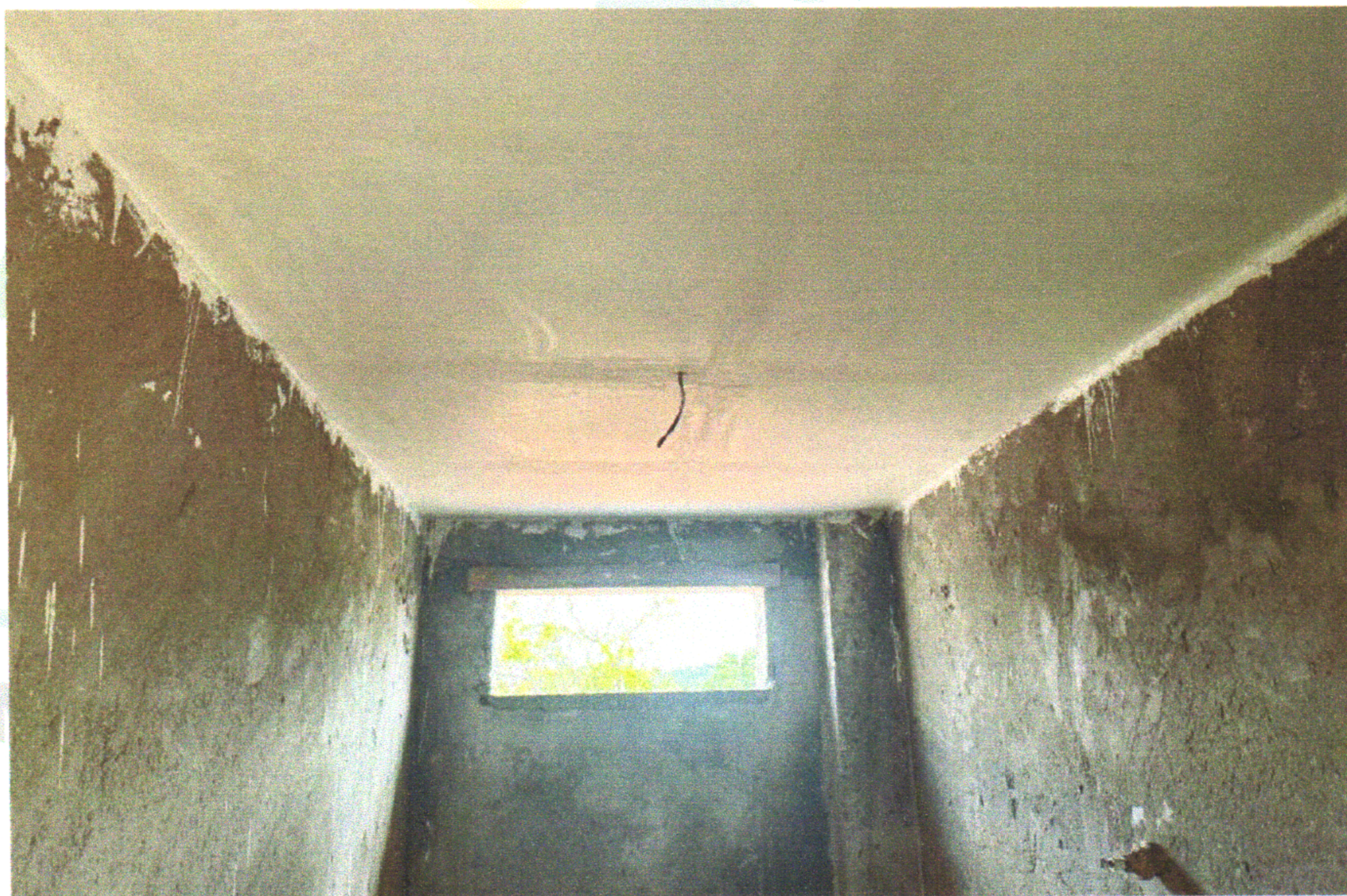
FOTO 11 (EXECUÇÃO DE FORRO DE GESSO)
