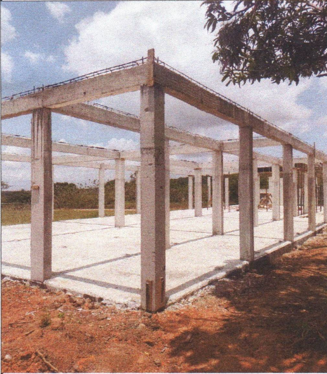
CONCRETO SUPERESTRUTURA-VIGAS
