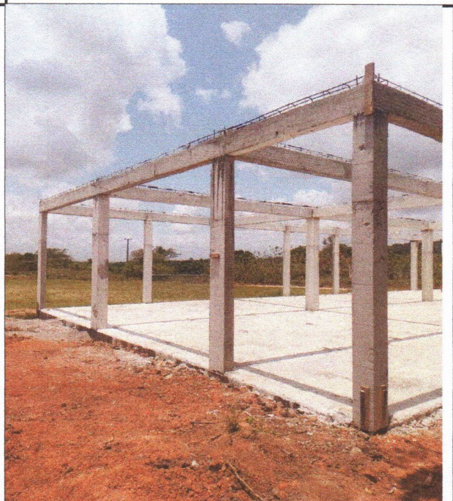
CONCRETO SUPERESTRUTURA-VIGAS
