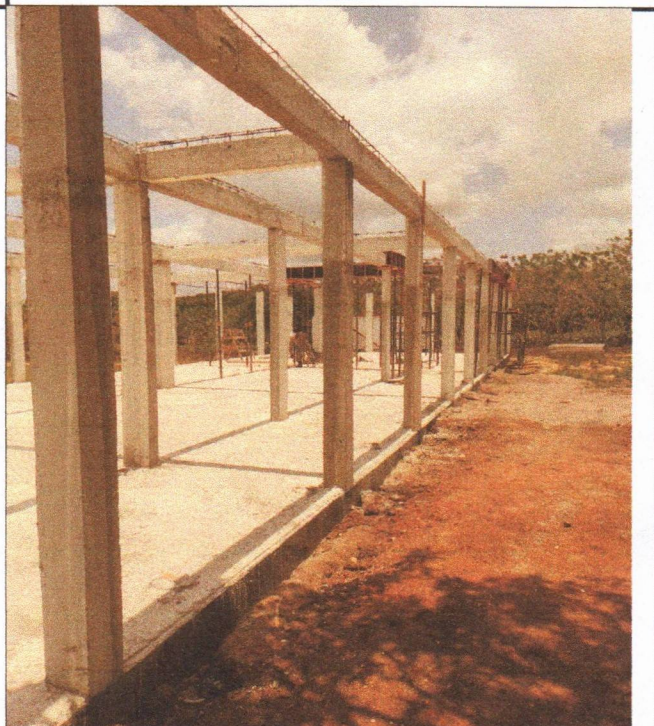
CONCRETO SUPERESTRUTURA-VIGAS
