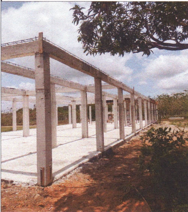
CONCRETO SUPERESTRUTURA-VIGAS
