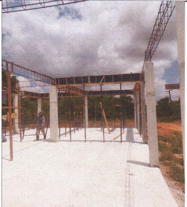
CONCRETO SUPERESTRUTURA-VIGAS
