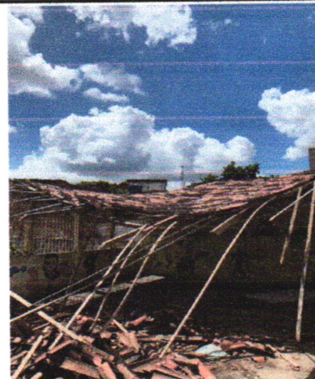
REMOÇÃO DE TELHAS - CRECHE DA RUA 18
