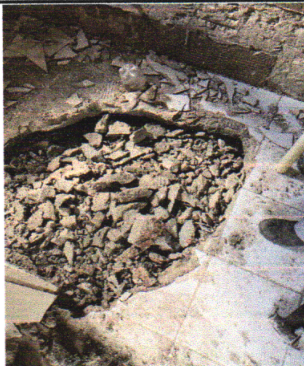
DEMOLIÇÃO DE PISO CIMENTADO - CRECHE DA RUA 18
