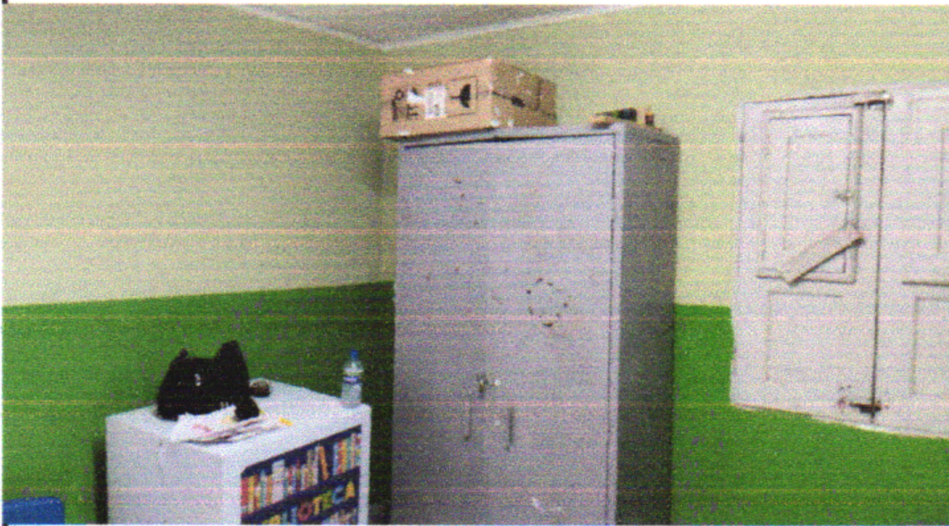
PINTURA DE PAREDES - CRECHE VOVÓ ISAURA
