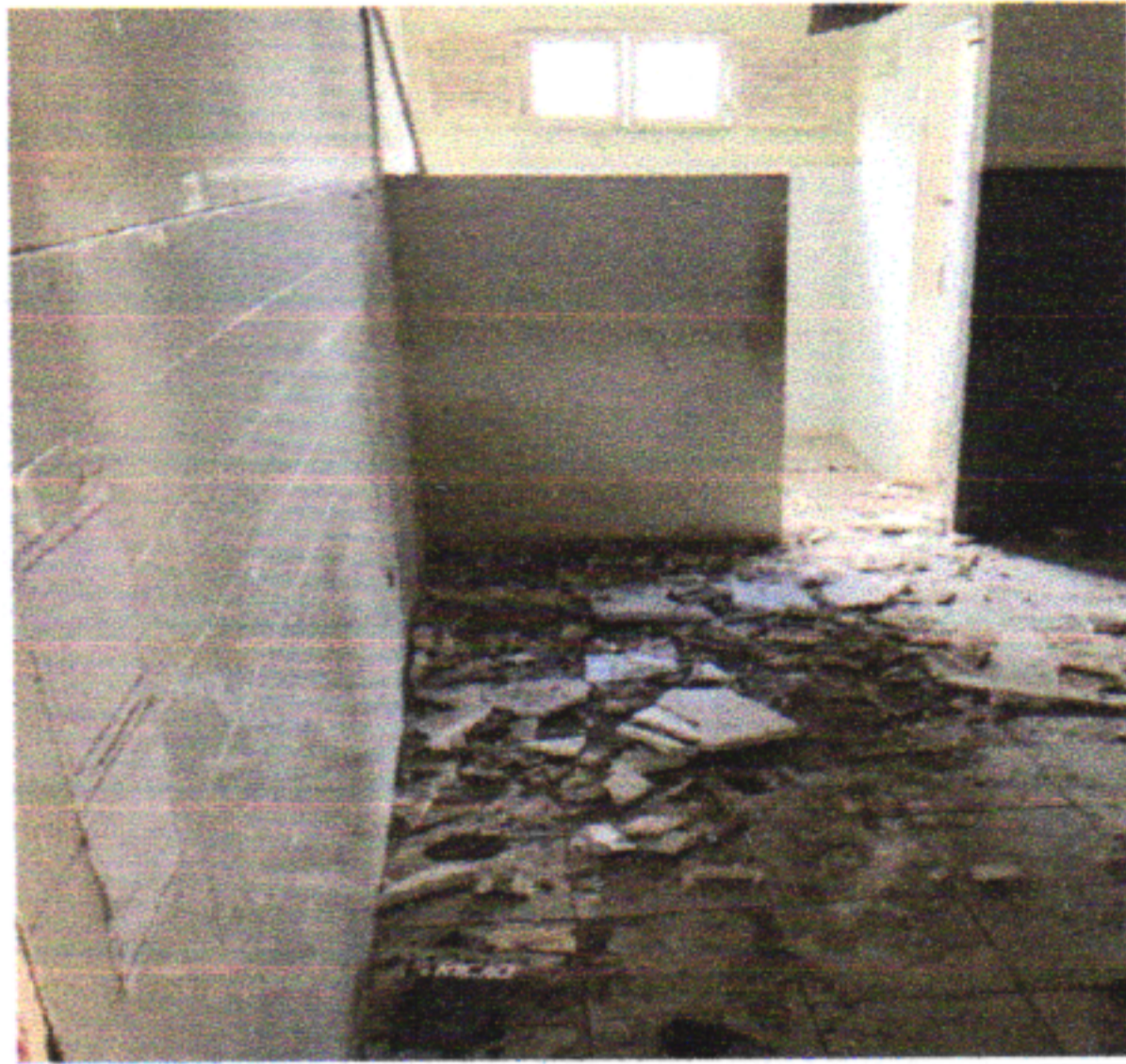
DEMOLIÇÃO DE ALVENARIA - CRECHE DA RUA 18
