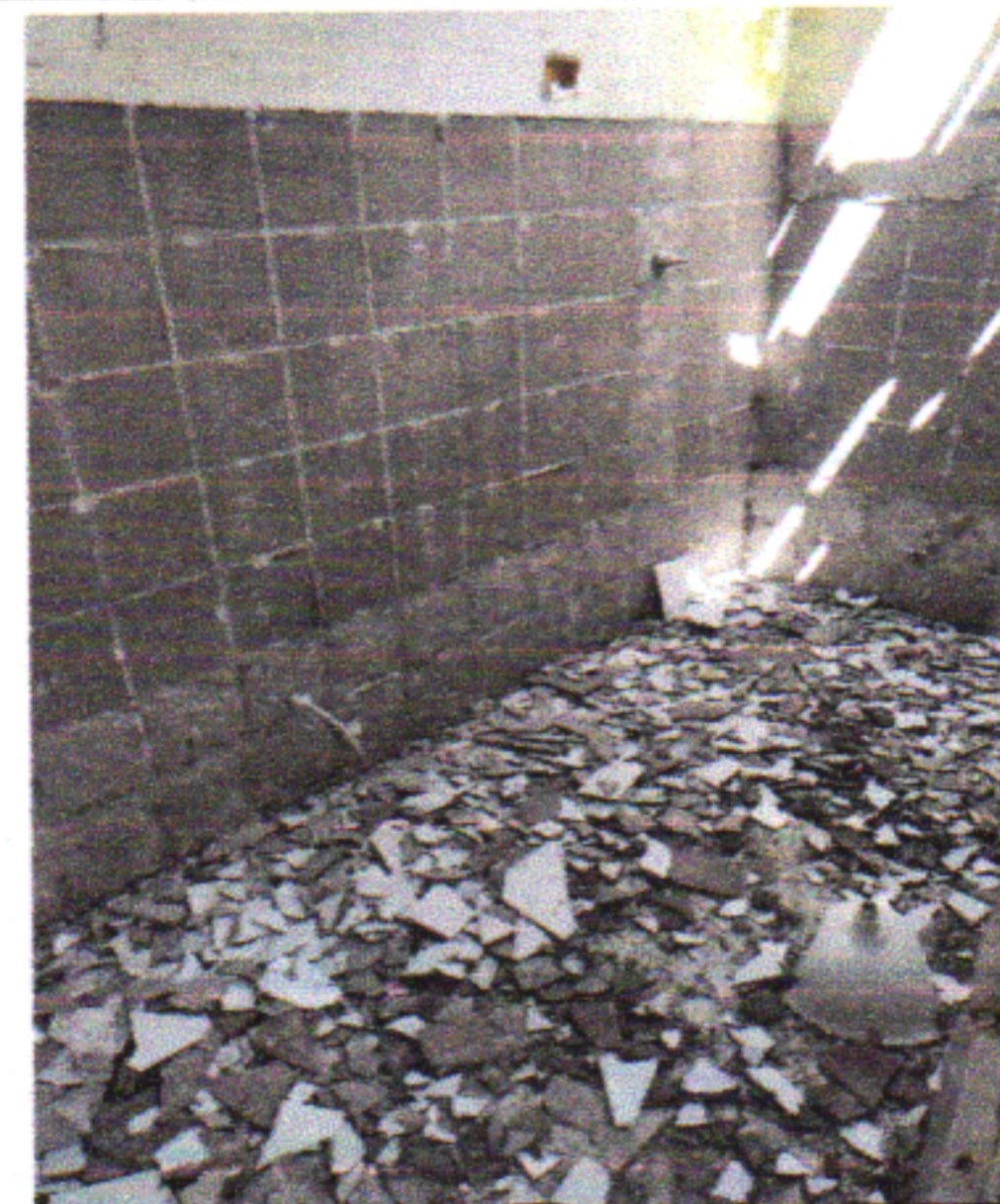
DEMOLIÇÃO DE REVESTIMENTO CERÂMICO - CRECHE DA RUA 18
