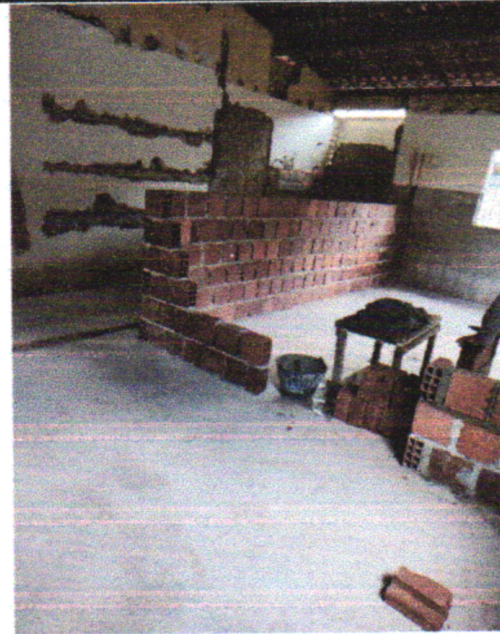
ALVENARIA - CRECHE RUA 18
