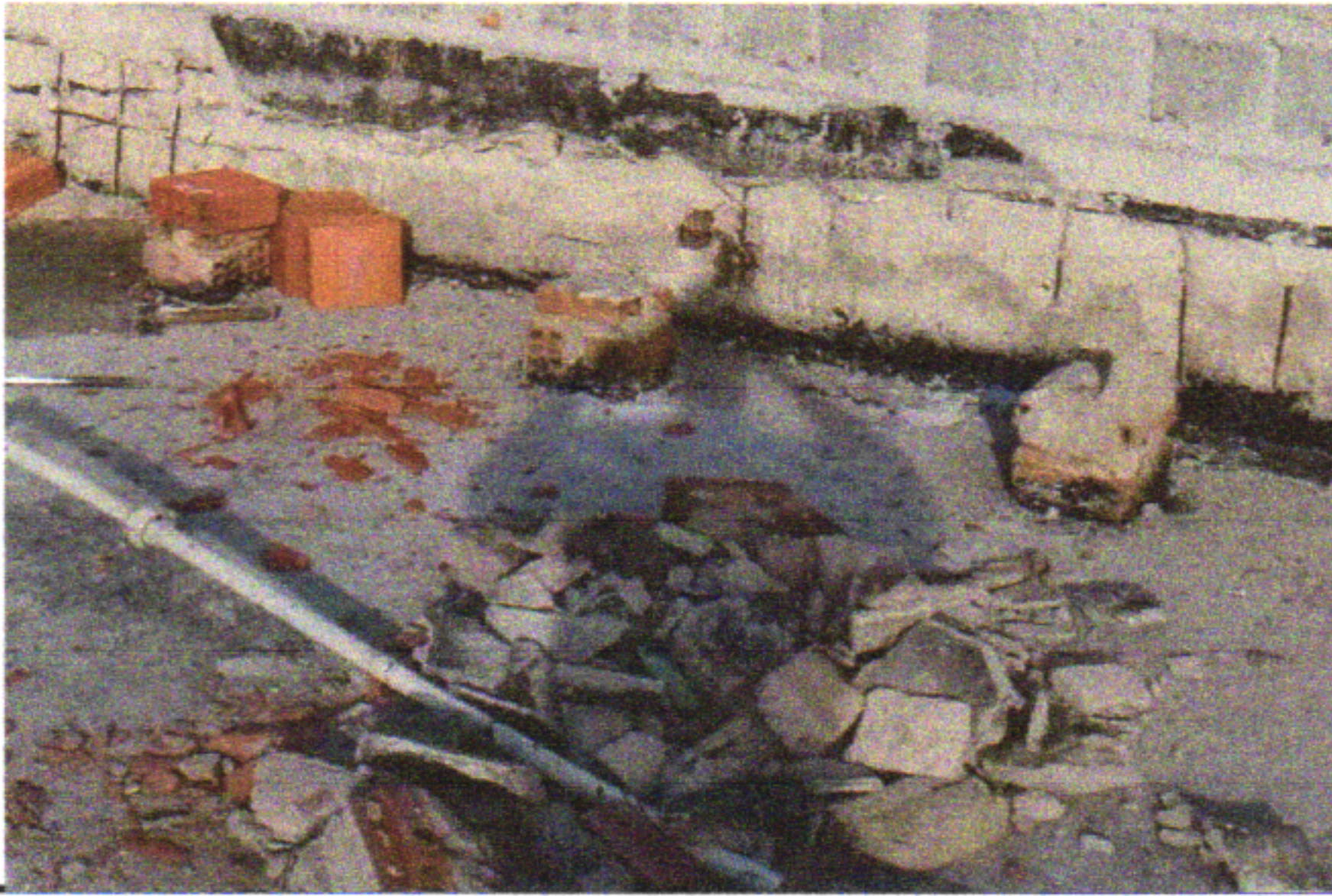
DEMOLIÇÃO ALVENARIA
