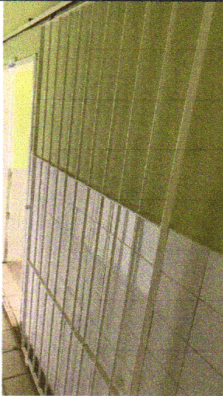
LIXAMENTO MANUAL EM SUPERFÍCIES METÁLICAS
