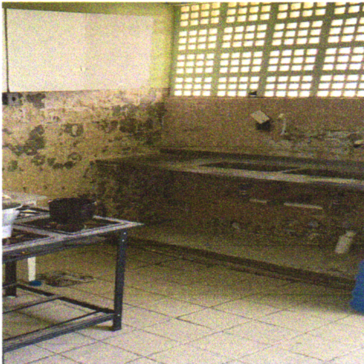
REMOÇÃO DE REVESTIMENTO CERÂMICA
