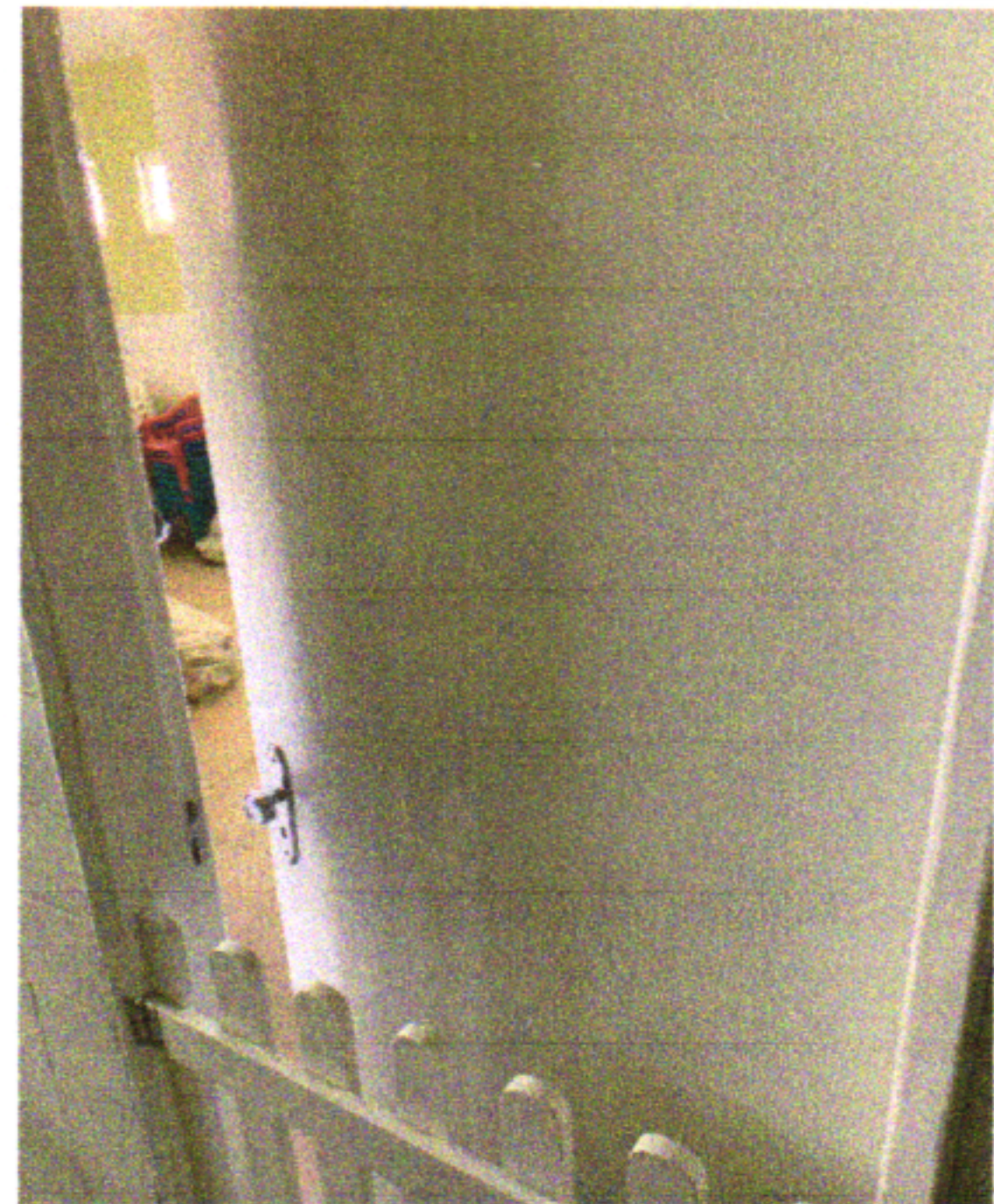
LIXAMENTO MANUAL EM SUPERFÍCIES DE MADEIRA
