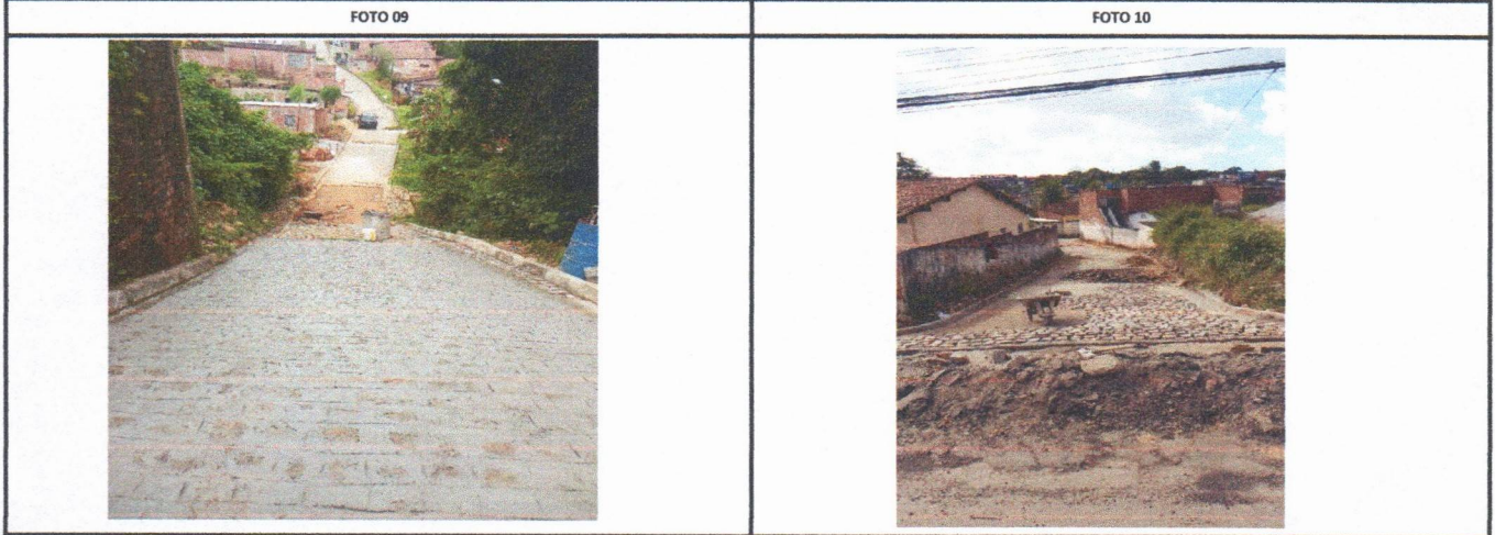
RUA FERNANDO CESAR RUA 23
