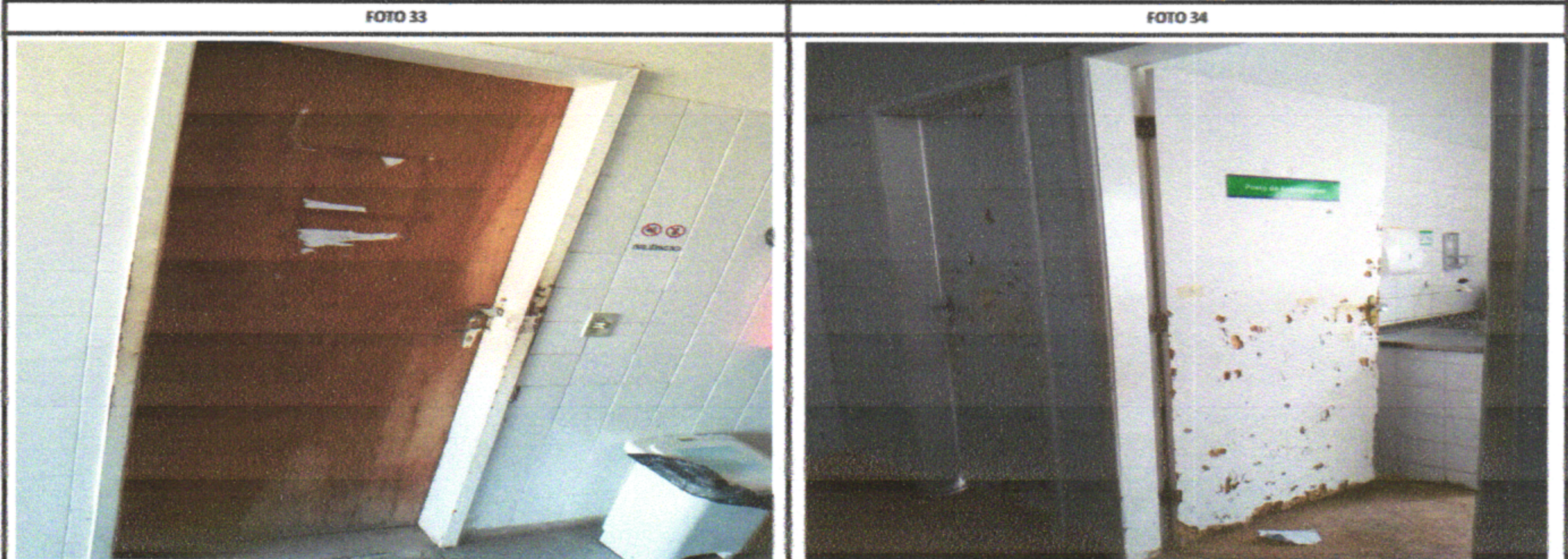
ANTES DA REFORMA ANTES DA REFORMA
