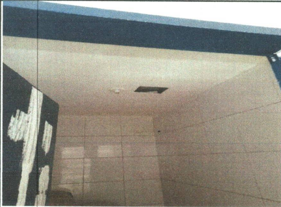
REMOÇÃO DE FORRO DE GESSO
