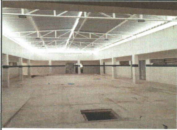
PISO EM GRANILITE DO PÁTIO INTERNO
