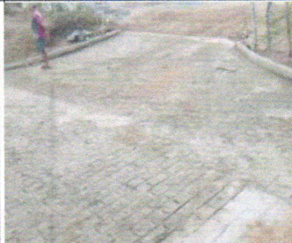
FOTO - 10: EXECUÇÃO DE PAVIMENTAÇÃO E GUIA-MEIO FIO
