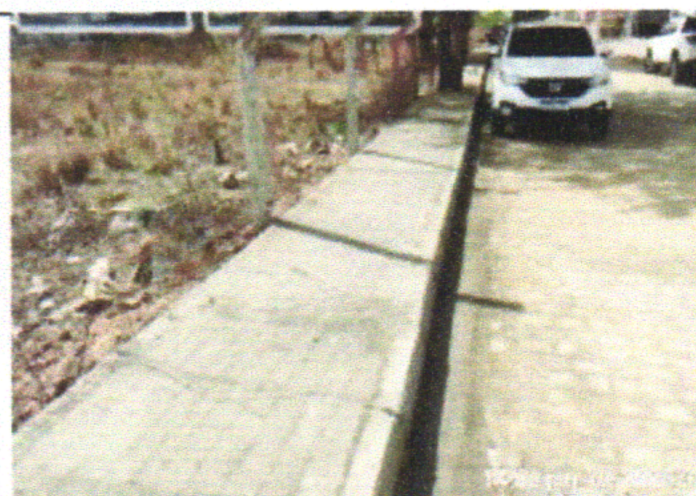
FOTO 14 - EXECUÇÃO DE SARJETA DE CONCRETO USINADO, MOLDADA IN LOCO EM TRECHO RETO, 30 CM BASE X 15 CM ALTURA. AF. 06/2016
