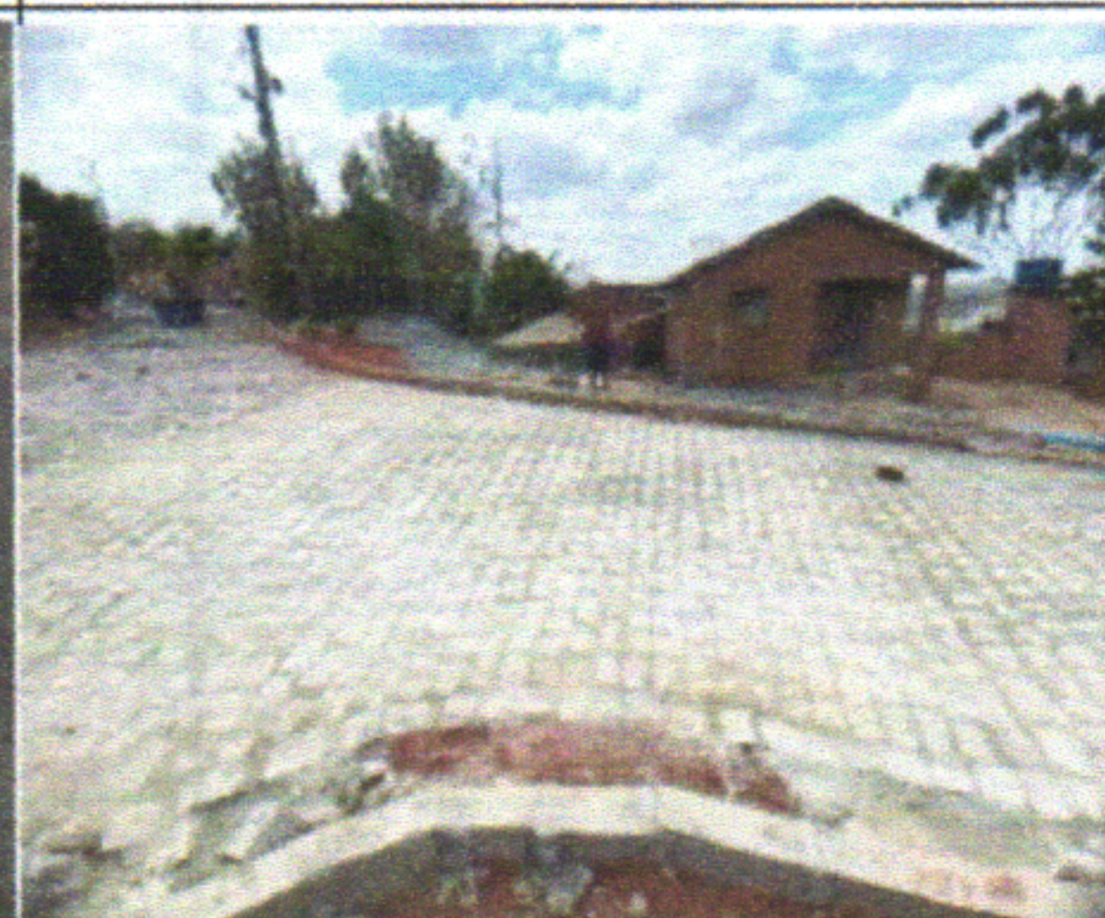
FOTO - 12: EXECUÇÃO DE PAVIMENTAÇÃO
