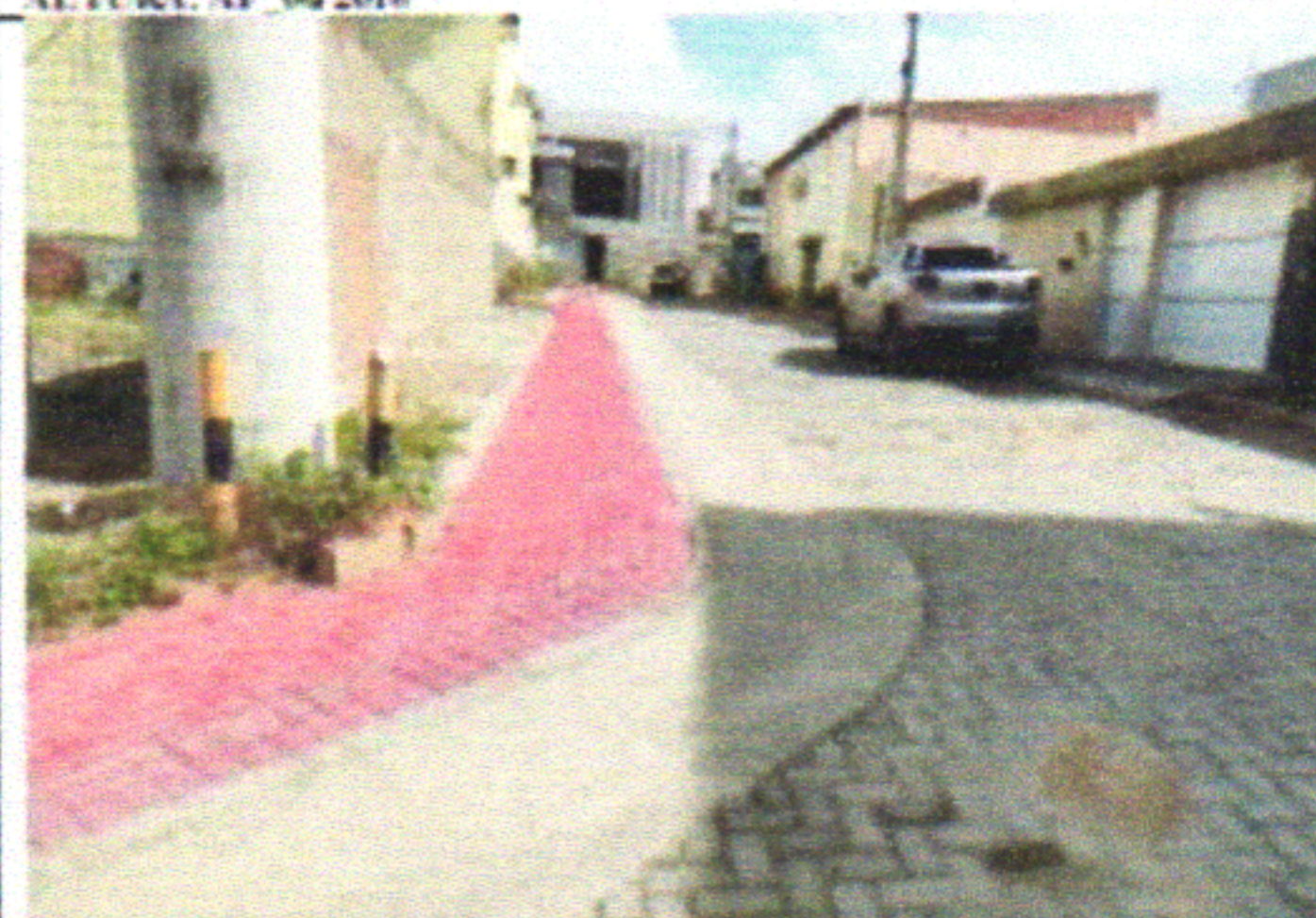
FOTO 16 - SARJETÃO DR 8, DE CONCRETO USINADO, MOLDADA IN LOCO EM TRECHO RETO, 90 CM BASE X 15 CM ALTURA - CONFORME O PROJETO.
