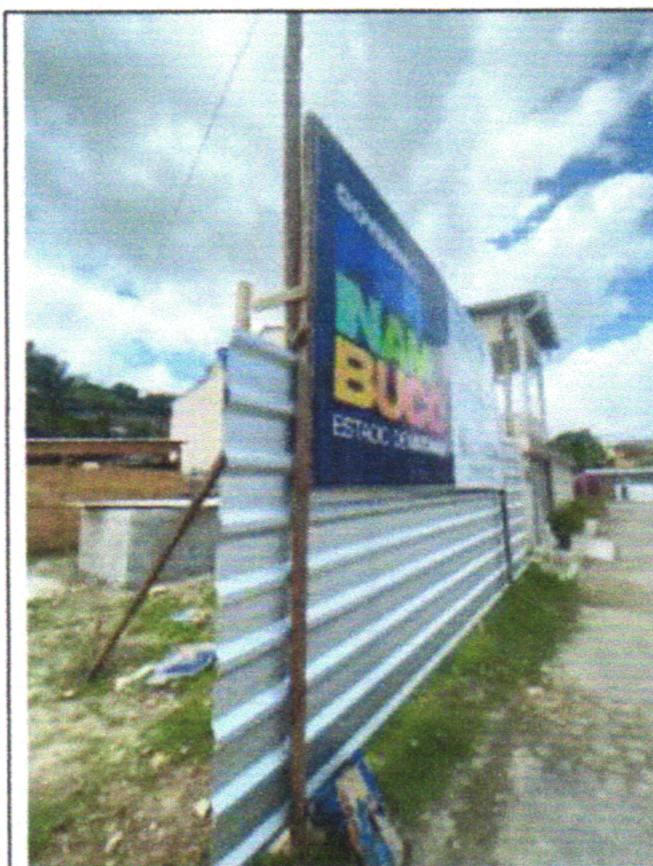
FOTO 01: PLACA DE OBRA INSTALADA
