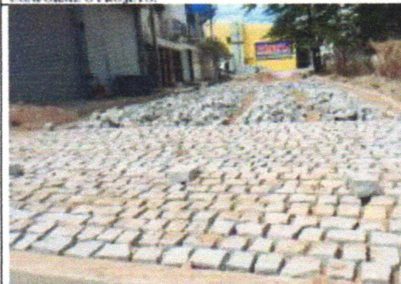
FOTO 17 - EXECUÇÃO DE PAVIMENTO EM PARALELEPÍPEDOS, REJUNTAMENTO COM ARGAMASSA TRAÇO 1:3 (CIMENTO E AREIA). AF. 05/2020
