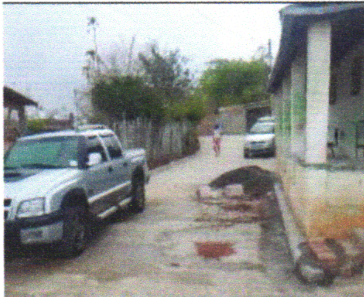
FOTO - 7: EXECUÇÃO DE PAVIMENTAÇÃO E GUIA-MEIO FIO
