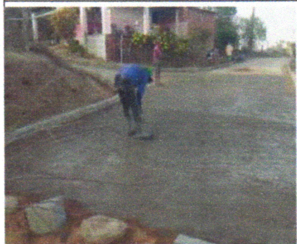
FOTO - 9: EXECUÇÃO GUIA-MEIO FIO
