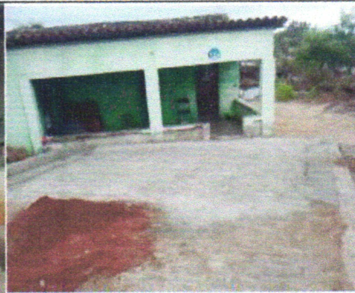
FOTO - 8: EXECUÇÃO DE PAVIMENTAÇÃO E GUIA-MEIO FIO
