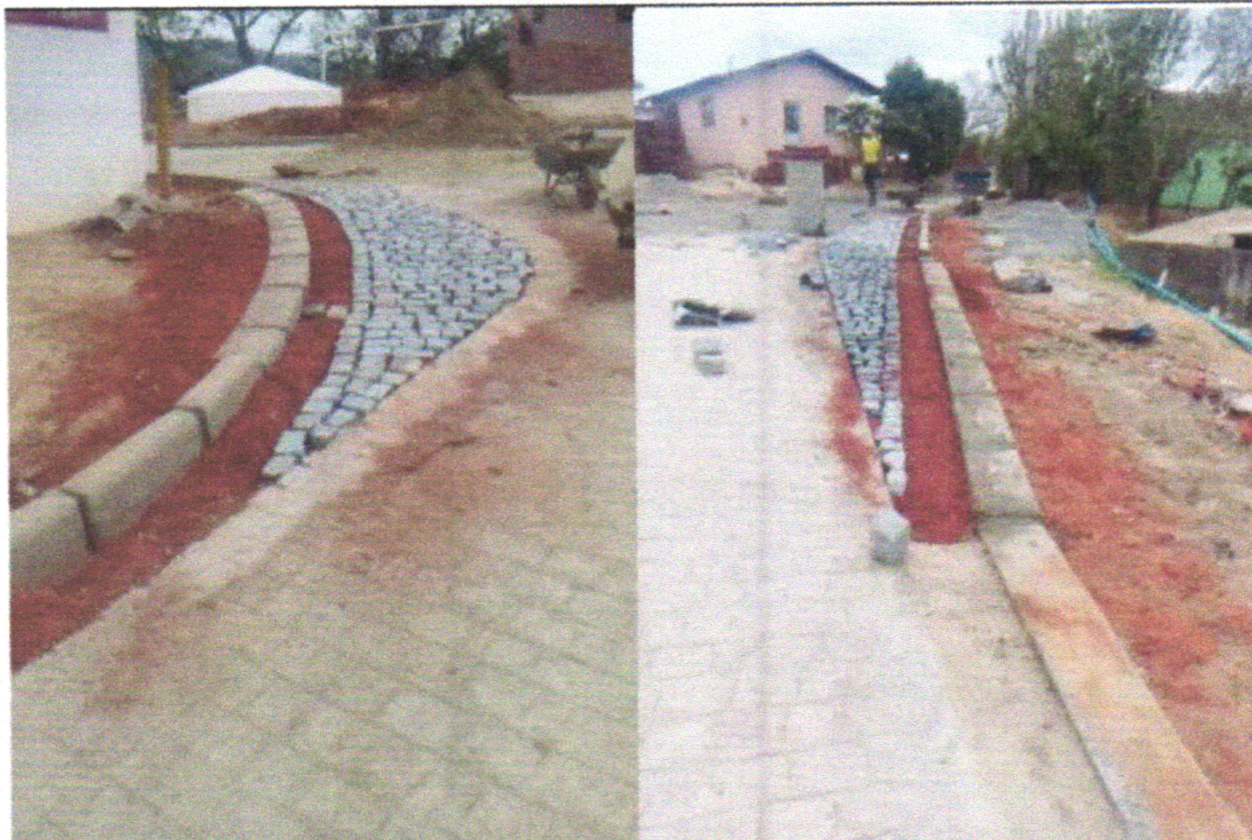
FOTO-13: EXECUÇÃO DE PAVIMENTAÇÃO
