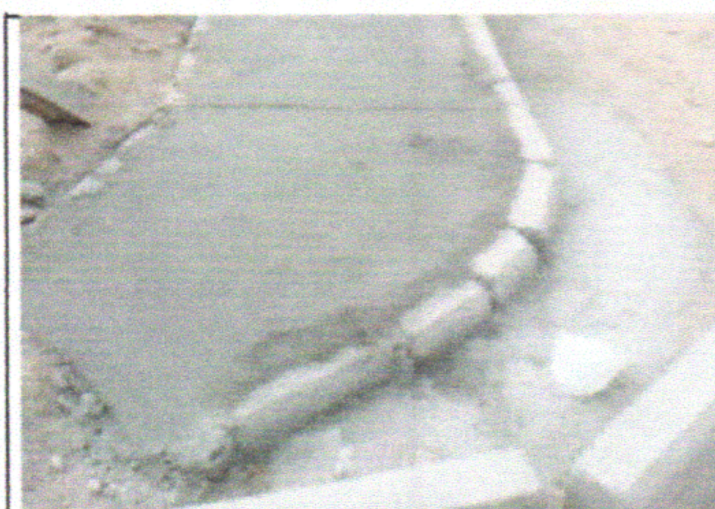
FOTO 13 - EXECUÇÃO DE SARJETA DE CONCRETO USINADO, MOLDADA IN LOCO EM TRECHO RETO, 30 CM BASE X 15 CM ALTURA. AF. 06/2016
