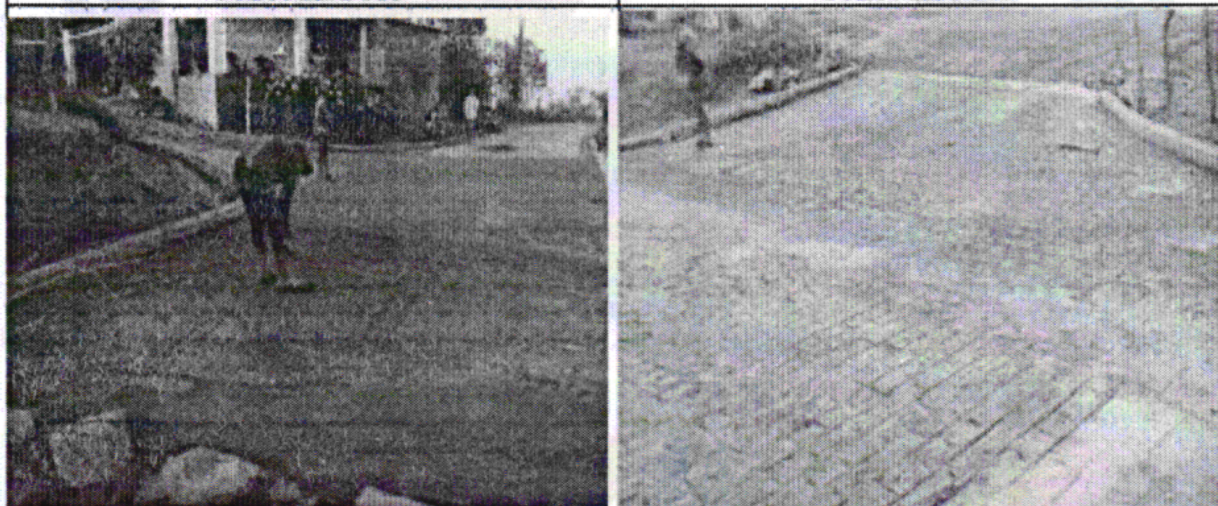
FOTO - 9: EXECUÇÃO GUIA-MEIO FIO
