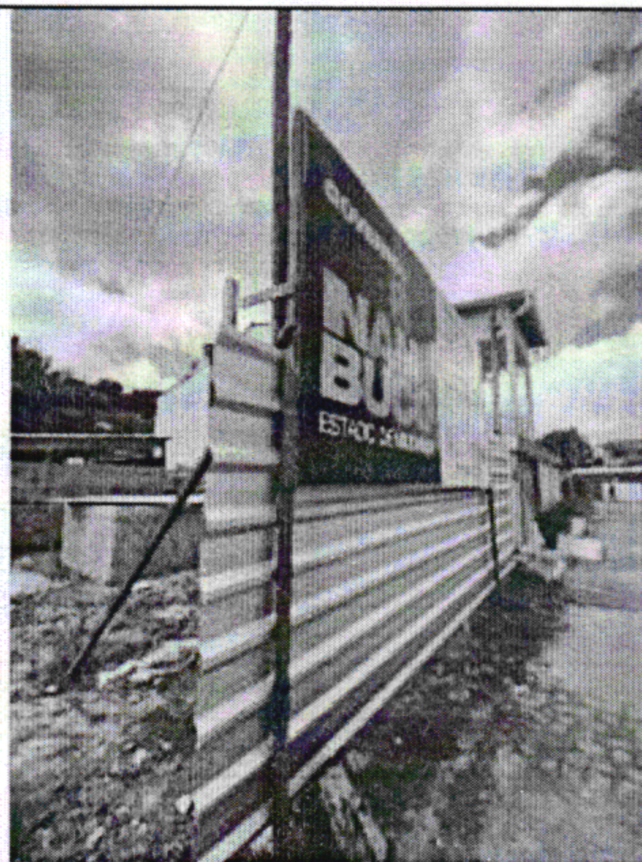
FOTO 01: PLACA DE OBRA INSTALADA
