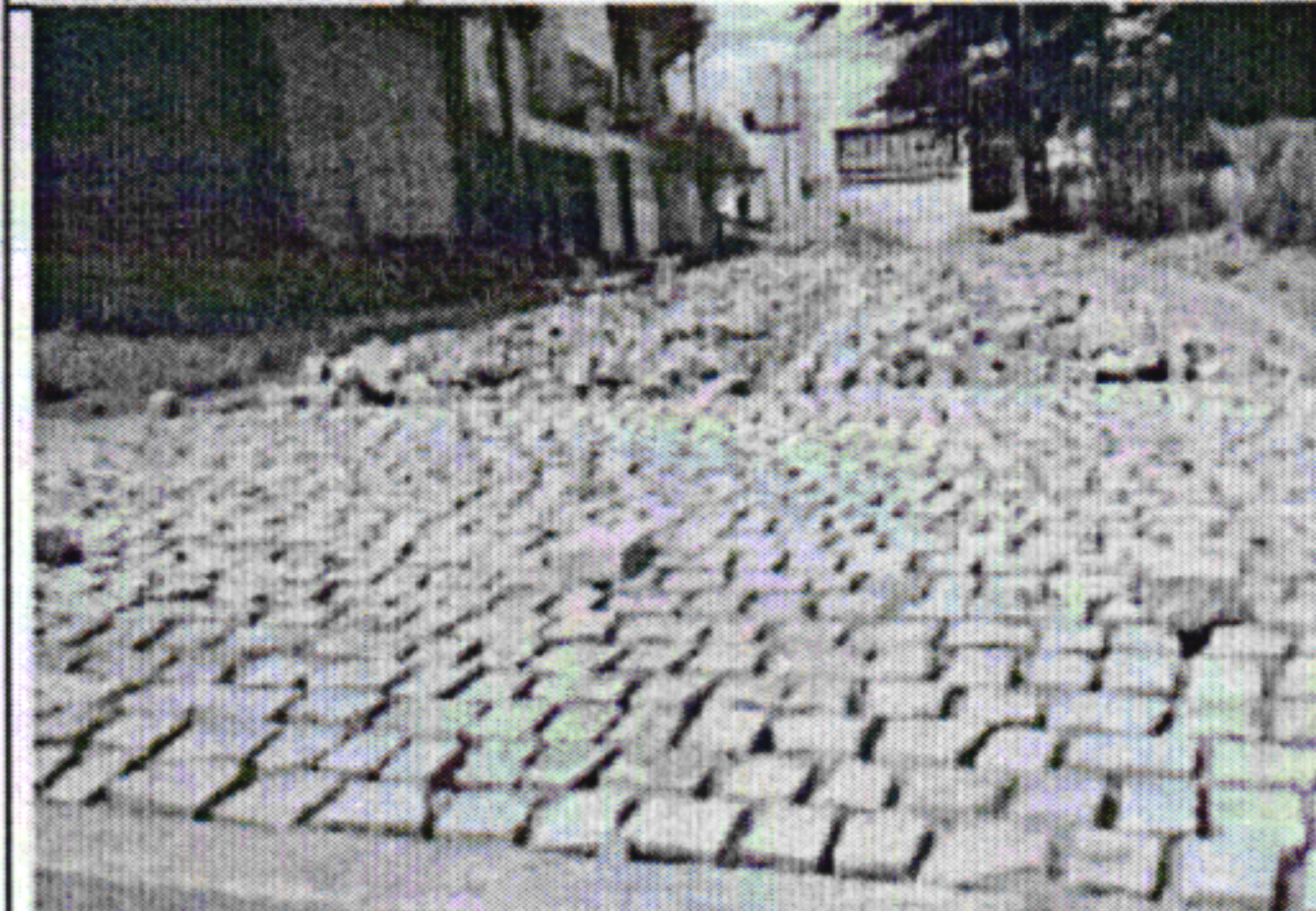
FOTO 17 - EXECUÇÃO DE PAVIMENTO EM PARALELEPÍPEDOS, REJUNTAMENTO COM ARGAMASSA TRAÇO 1:3 (CEMENTO E AREIA). AF. 05/2020
